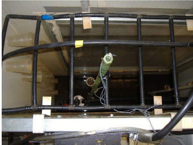
Figura 4 – Termopares e bomba circuladora de água.
