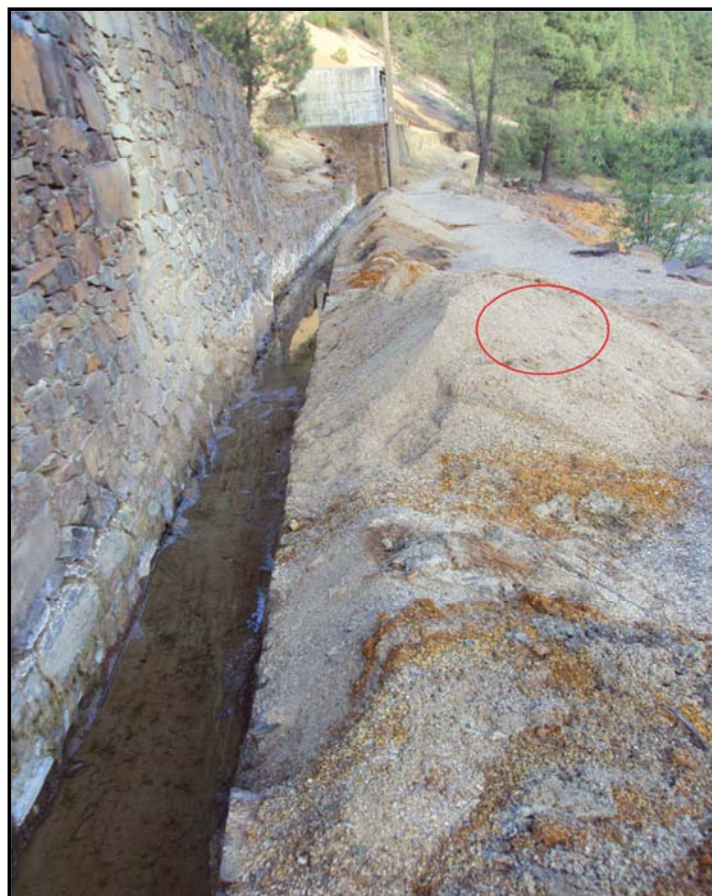
Fig. 45. Tramo final da conduta superficial antes de entrar na Estação de Bombagem ao fundo, em que visível o ponto onde se amostrou o solo BE1* em escombros que recobria a conduta, mas que foi manualmente retirado por funcionários da Beralt .
