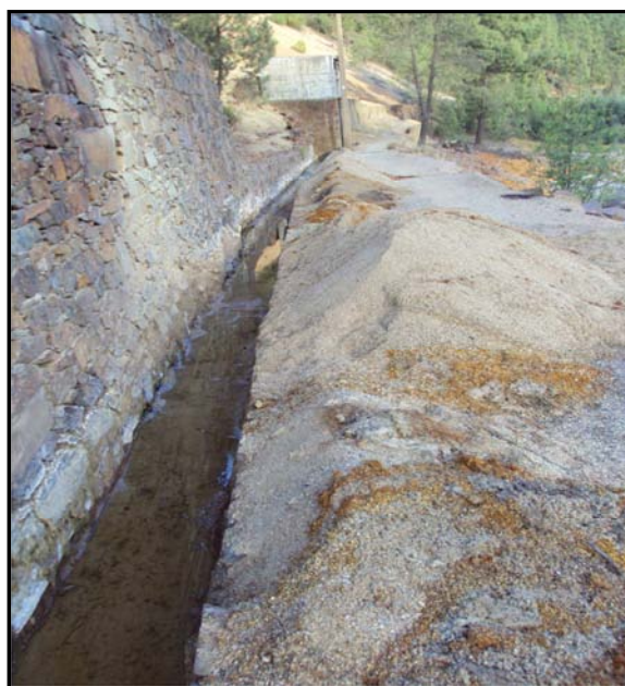
Fig. 59. Vista do local de recolha de A7 para a Estação de Bombagem, em que é possível observar material de escombro que estava a tapar a conduta e posteriormente foi removido pelos funcionários da mina.
