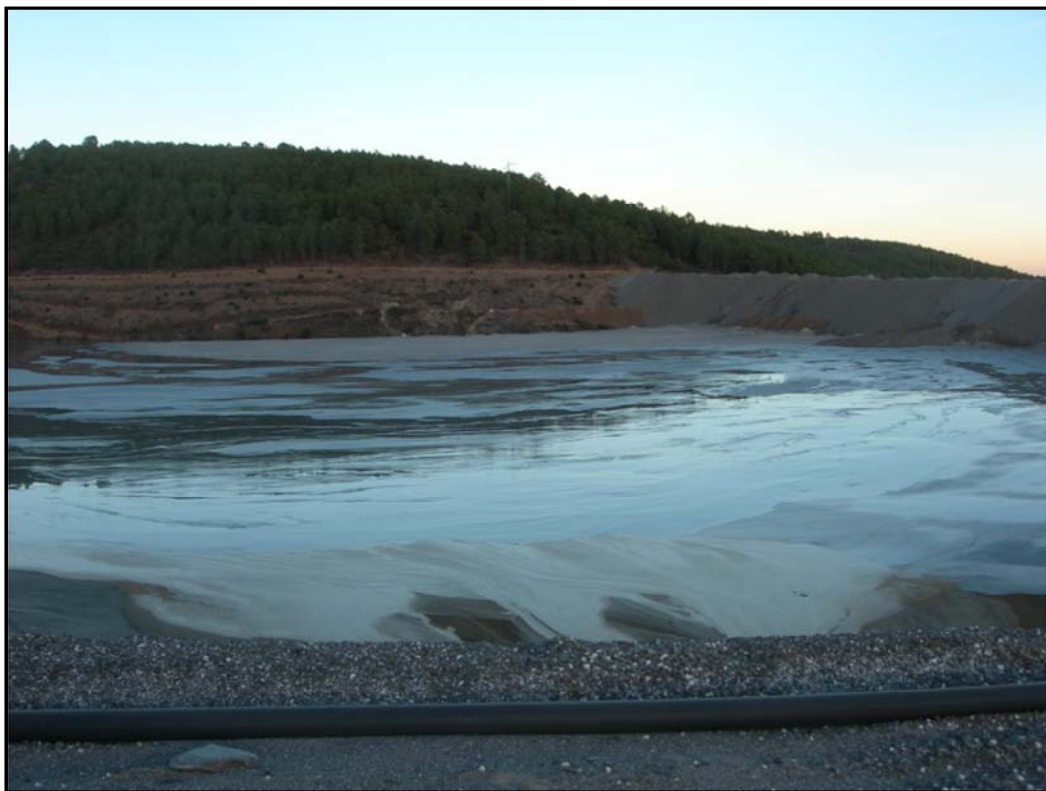
Fig. 15. Vista de uma das Barragens de Lamas Nova, em cima da Escombreira Nova, na aldeia da Barroca Grande.
