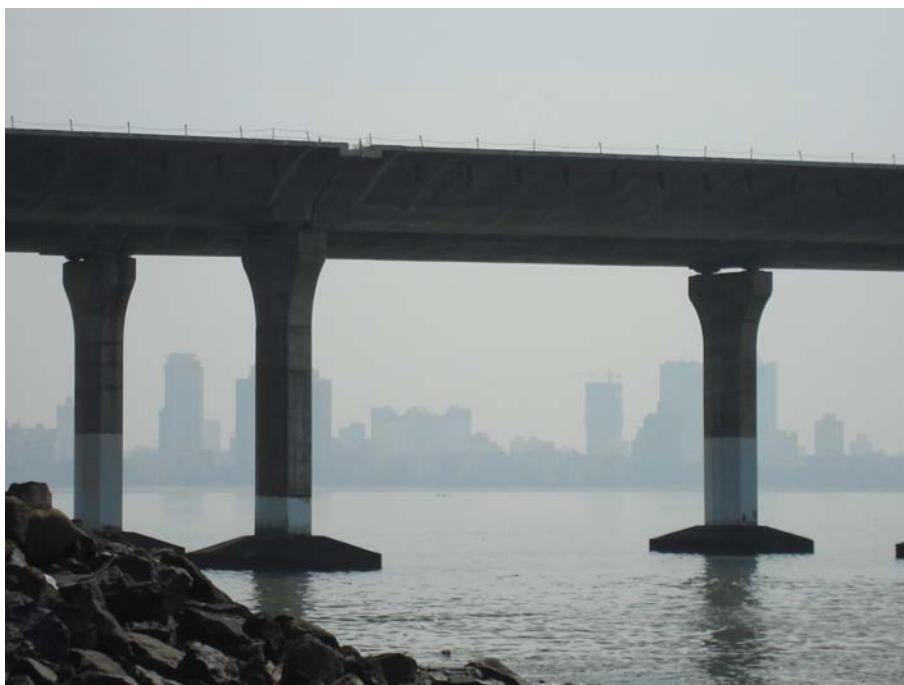
Figura 21 – Ponte Bandra-Worli e skyline de Bombaim
