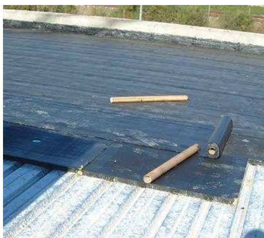
Fig. 35 – Aplicação do sistema de impermeabilização
