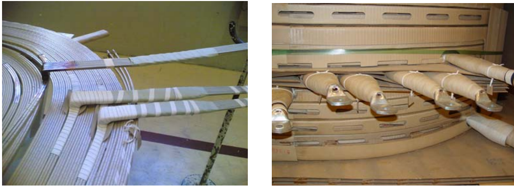
Figura 11 – Tomadas em processo e Tomadas concluídas já com terminal
