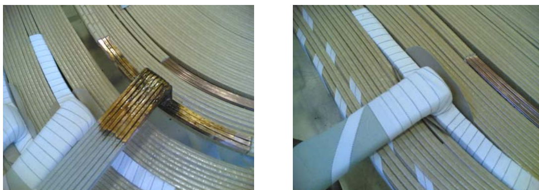
Figura 22 - Cabeça de tomada soldada e Cabeça de tomada já isolada
