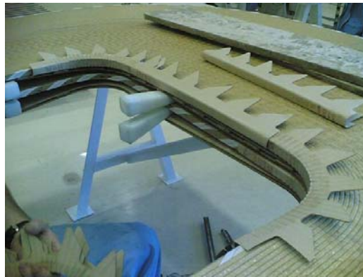
Figura 21 – Moldados de preparação
