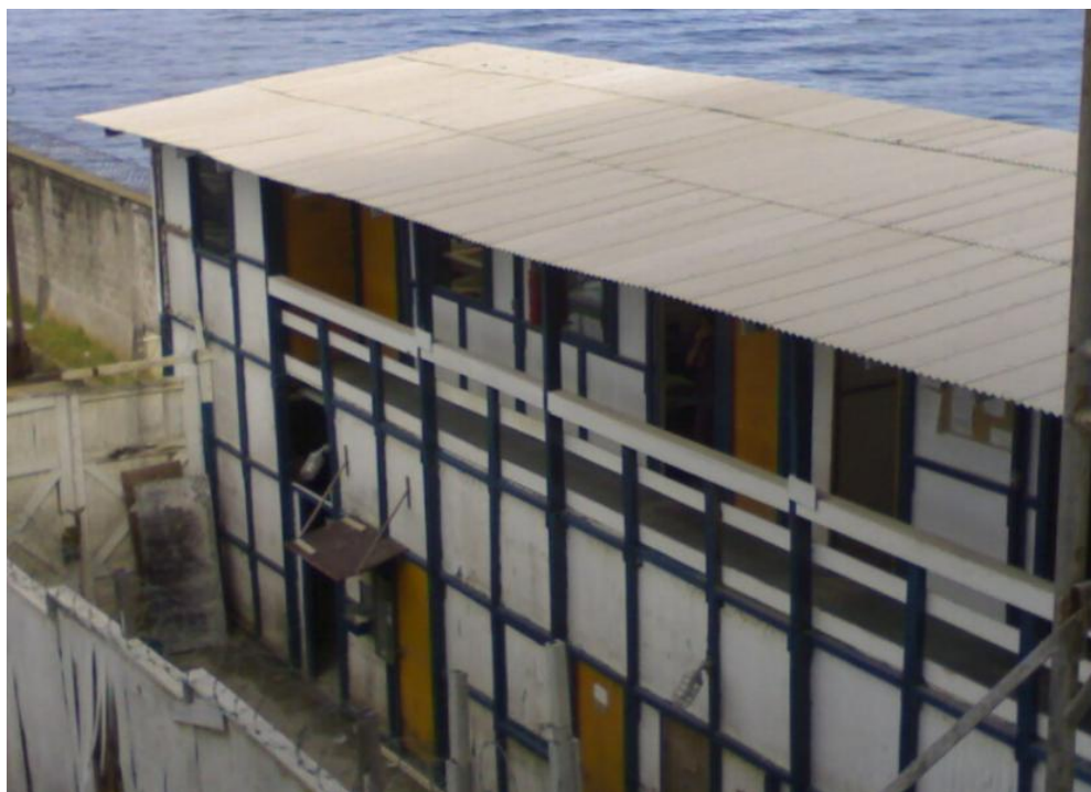
Fig.4.4 – Estaleiro de obra
