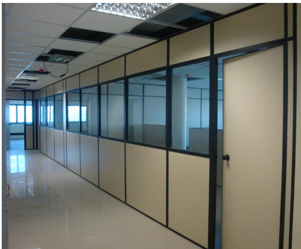
Fig. 5.2 – Divisórias internas finalizadas
