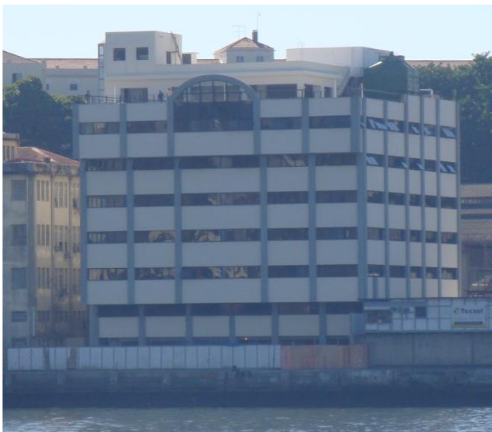
Fig.4.1 – Fachada sul do edifício em estudo
