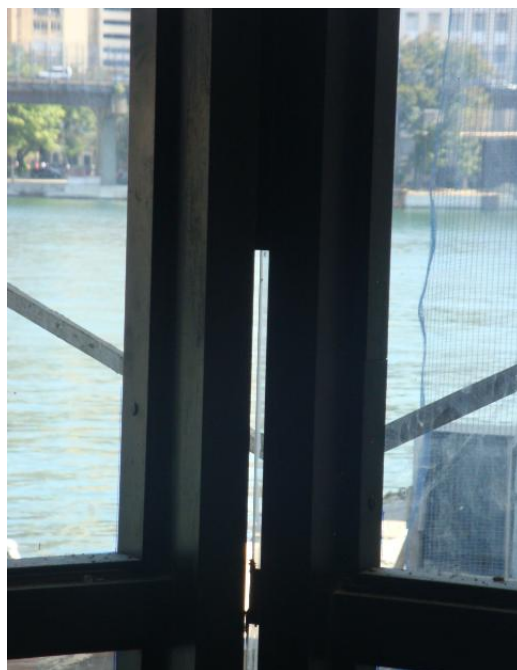
Fig. 5.19 – Pormenor da vedação entre vidros no elevador panorâmico
