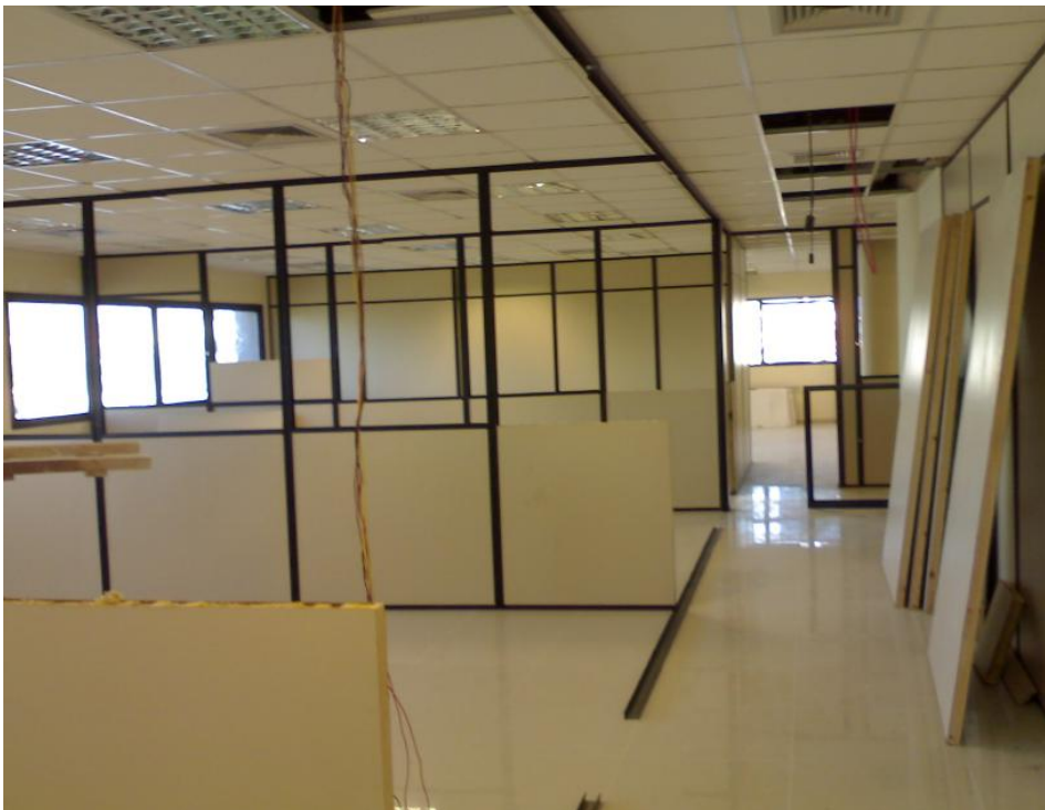
Fig. 5.1 – Colocação das divisórias internas
