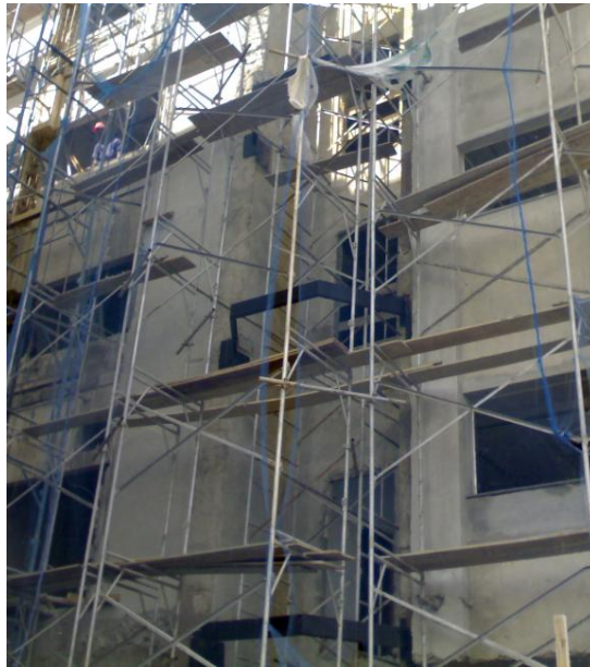
Fig. 5.17 – Estrutura de suporte para aplicação da esquadria dos vidros do elevador panorâmico
