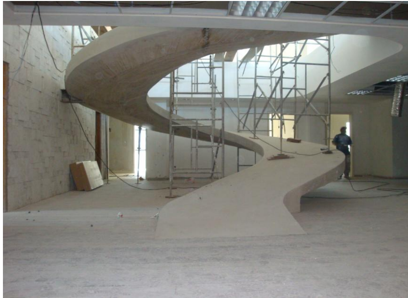
Fig. 5.10 – Aplicação do piso de madeira concluída
