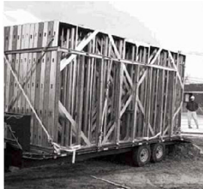
Figura 4.2. - Painéis pré-fabricados de LSF. [12]
