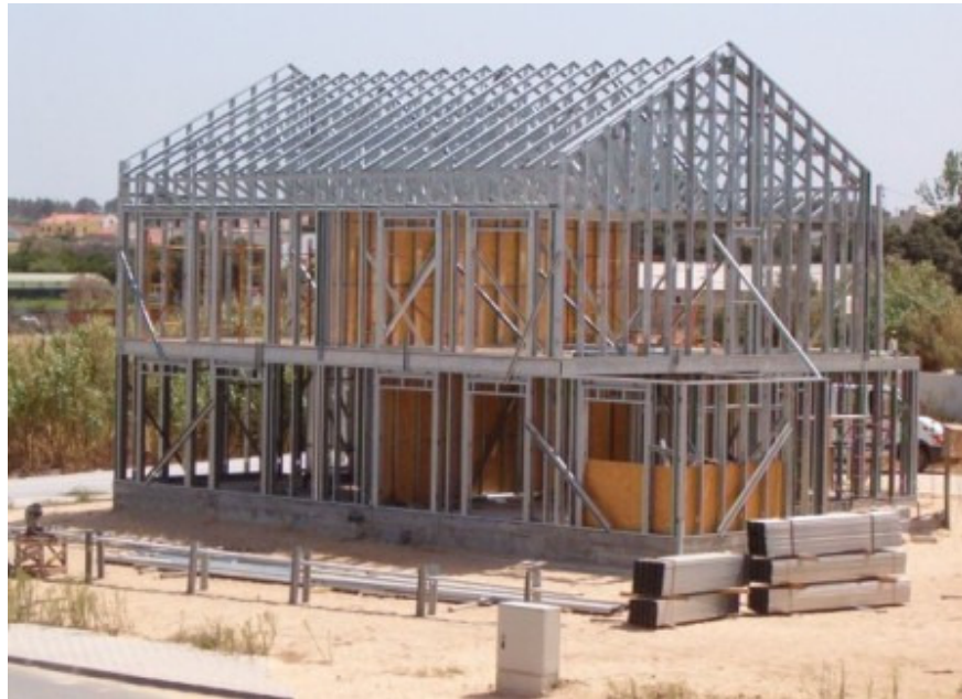
Figura 2.15. – Exemplo de estrutura em aço galvanizado leve antes da aplicação de revestimentos.
