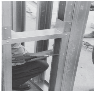
Figura 4.9. - Travamento horizontal dos painéis estruturais. [12]
