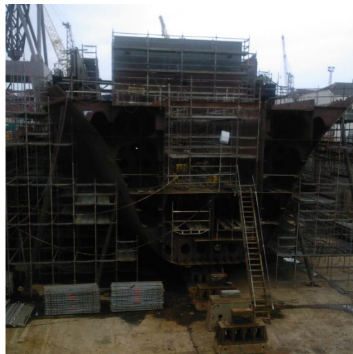
Figura 1.2.4 - Construção 254 em fase de construção
