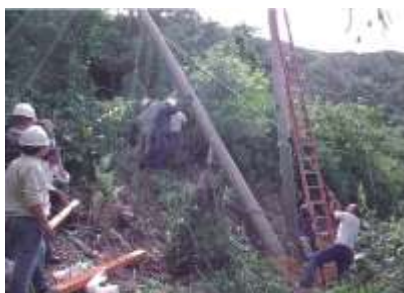
Ilustração 50 Arvoreamento de um poste em compósito
