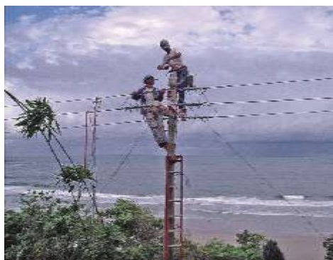
Ilustração 51 Ligação de um poste em compósito
