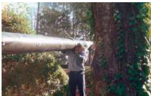
Ilustração 61 Transporte de poste a local de difícil acesso
