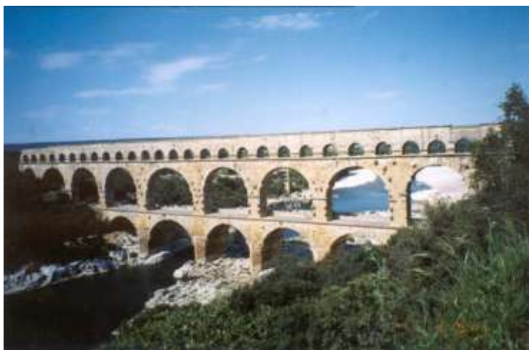
Ilustração 19 Aqueduto da Pont du Gard em Nimes
