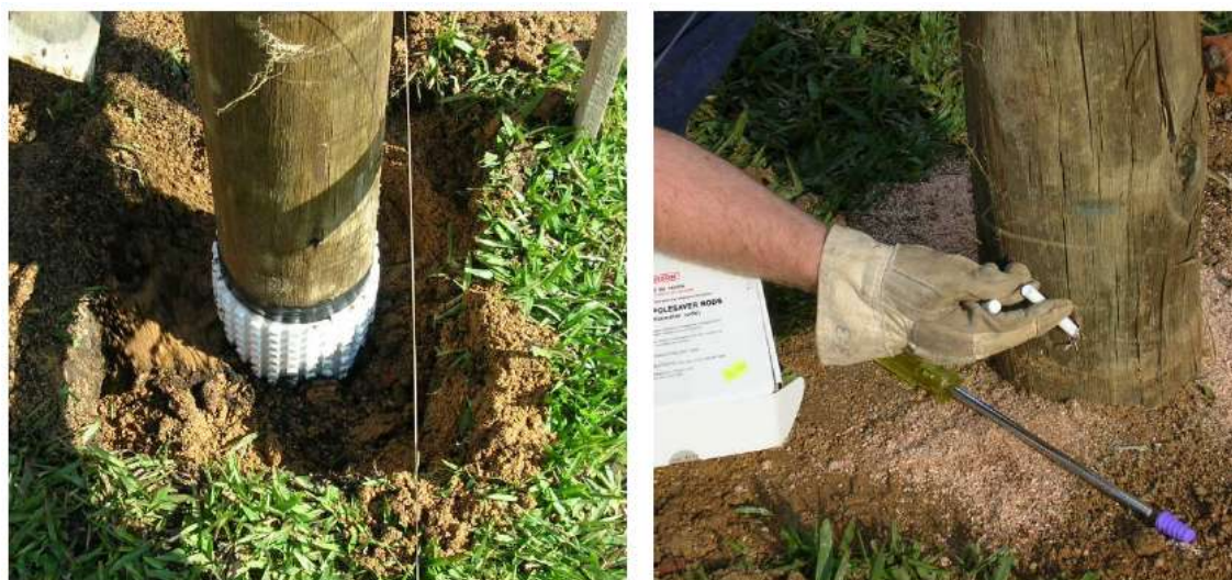
Ilustração 43 Tratamento dos postes de madeira
