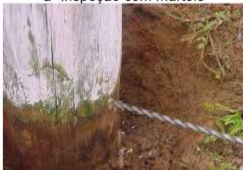
c- Furo para inspeção interna
