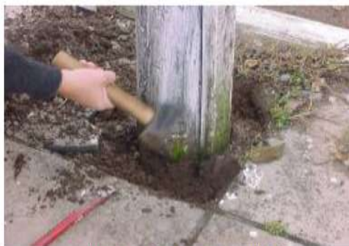
a- Inspeção com martelo
