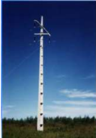
Ilustração 27 Poste em duplo T, usado na Europa
