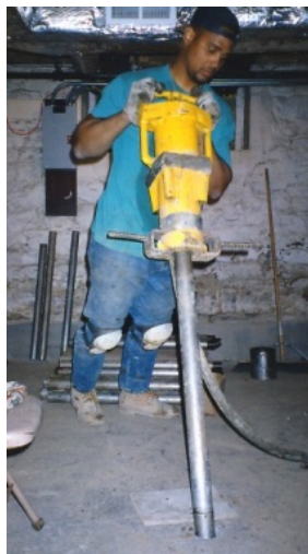
Figura 2.22 – Manobrador a utilizar o equipamento da metodologia Compaction Grouting .
