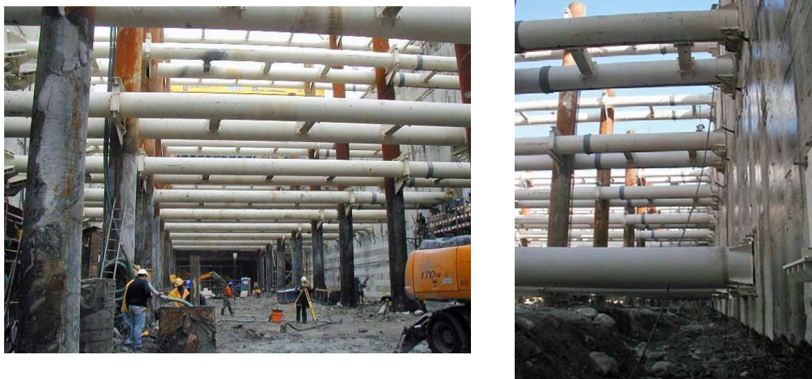
Figura 3.2 – Aparência da obra durante a empreitada ( www.cenor.pt ).
