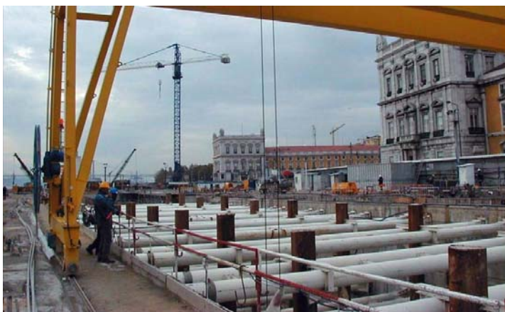
Figura 3.1 – Envolvente da escavação para a construção da estação Terreiro do Paço ( www.cenor.pt ).
