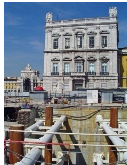
Figura 3.1 – Envolvente da escavação para a construção da estação Terreiro do Paço ( www.cenor.pt ).
