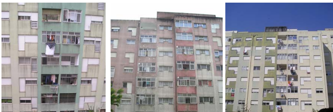
Figura 4.57 - Fachadas onde são visíveis vários modelos distintos de caixilharia nas lavandarias.
