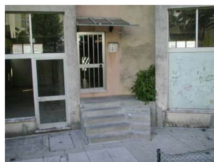
Figura 4.19 - Coberto colocado numa entrada de tipologia de “ângulo” (posterior)
