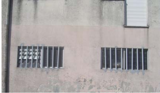
Figura 4.64 - Colocação de grades pelo exterior dos arrumos.
