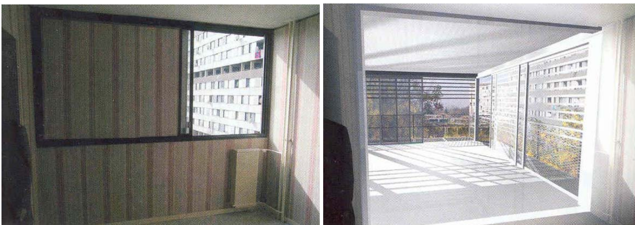
Figura 2.7 - Sala - antes e depois da abertura na fachada e ampliação do compartimento.
