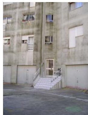
Figura 4.41 - Entrada principal de tipologia de “ângulo”.
