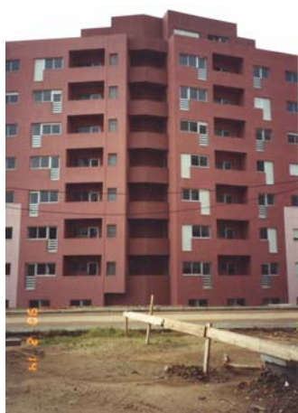
Figura 3.8 - Edifício de tipologia de “ângulo”, bloco 16.
