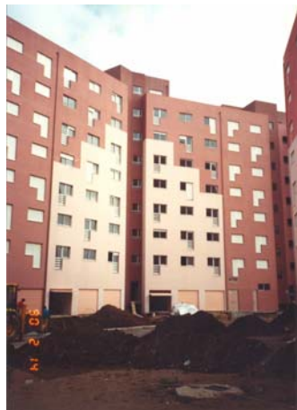
Figura 3.9 - Edifício de tipologia de “ângulo”, bloco 16.
