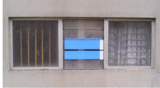
Figura 4.65 - Colocação de grades pelo interior dos arrumos.
