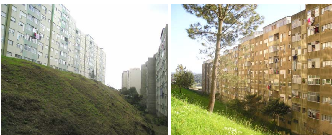
Figura 5.33 - Espaços exteriores com fortes pendentes e por isso de difícil uso..
