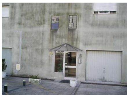
Figura 4.16 - Coberto colocado numa entrada de tipologia “plana”.
