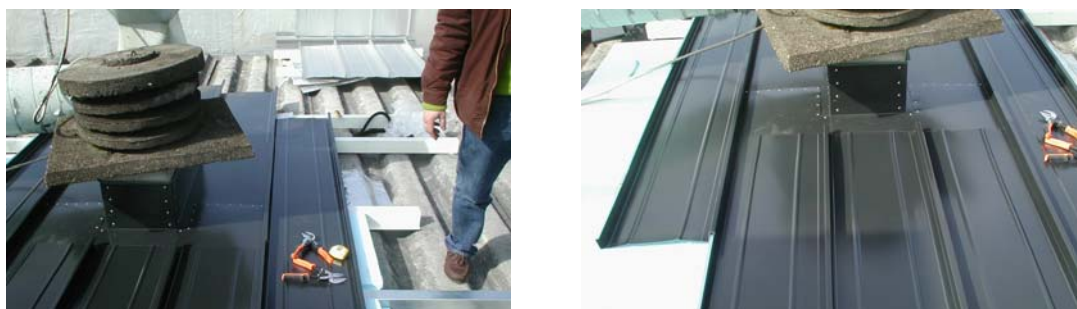
Figura 4.73 - Ensaio de aplicação da nova cobertura proposta sobre cobertura de fibrocimento existente.
