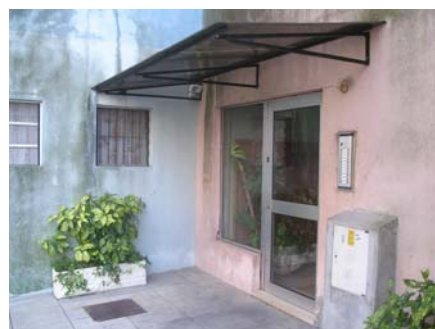
Figura 4.17 - Coberto colocado numa entrada de tipologia de “topo”.
