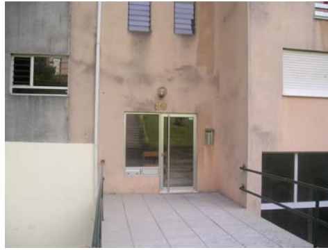
Figura 4.48 - Entrada de tipologia de “topo” através de “passerelle”. Esta entrada apresenta uma configuração única em toda a urbanização.
