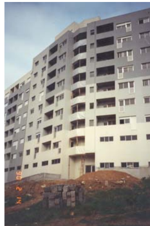
Figura 3.10 - Edifício de tipologia de “ângulo”, bloco 15.
