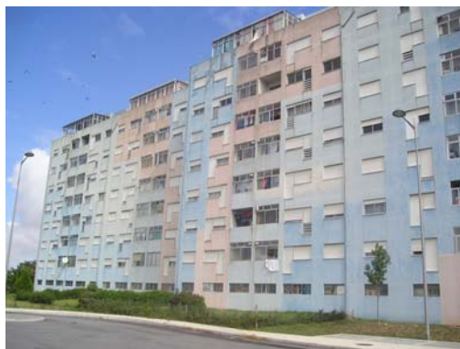
Figura 3.5 - Edifício de tipologia “plana”, bloco 10.
