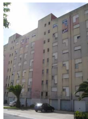
Figura 3.6 - Edifício de tipologia “plana”, bloco 3.
