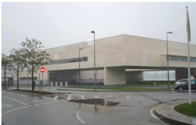
Figura 3.65 – Exterior da Biblioteca Municipal de Viana do Castelo. [Fotografia do autor]
