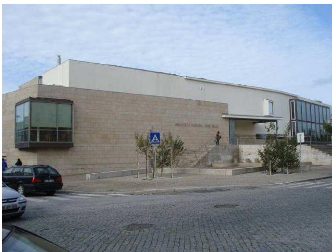
Figura 3.68 – Exterior da Biblioteca Municipal José Régio. [Fotografia do autor]
