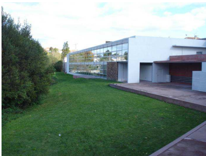
Figura 3.62 – Exterior da Biblioteca Municipal Professor Joaquim Pires de Lima. [Fotografia do autor]
