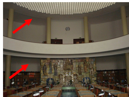
Figura 7.10 – Fotografia do semicírculo da galeria onde será colocado o tecto falso.
