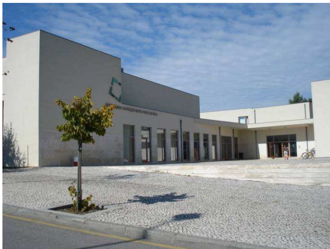
Figura 3.71 – Exterior da Biblioteca Municipal de Santa Maria da Feira. [Fotografia do autor]
