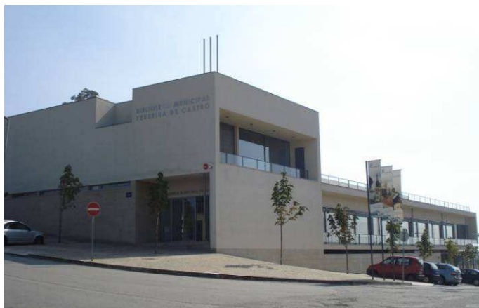
Figura 3.48 – Exterior da Biblioteca Municipal Ferreira de Castro. [Fotografia do autor]
