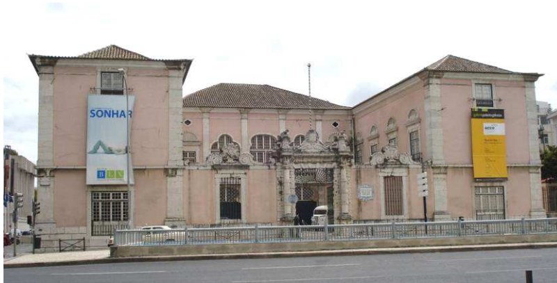
Figura 3.11 – Exterior da Biblioteca Municipal Central – Palácio Galveias. [Fotografia do autor]
