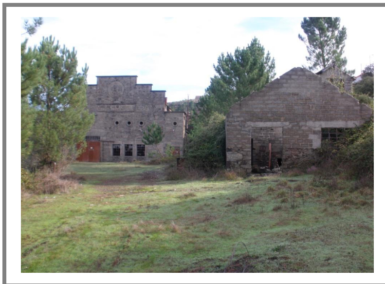
Figura 23 - Fundição e Casa do Moinho
