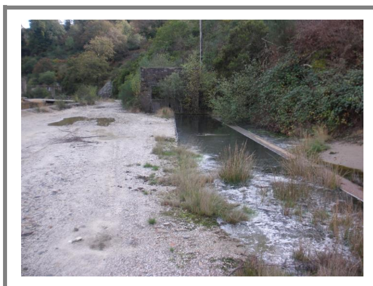
Figura 21 - Tanques de decantação.
