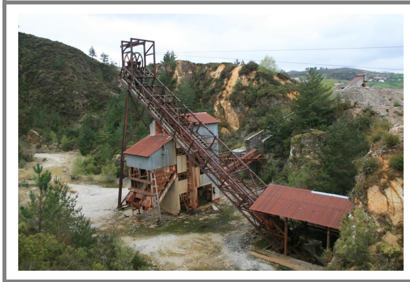
Figura 26 - Caveleto da mina subterrânea
