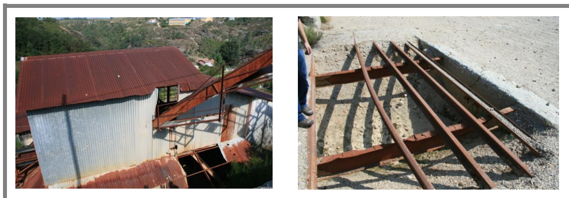
Figura 28 – Casa do silo de alimentação da lavaria e grade de alimentação do britador
