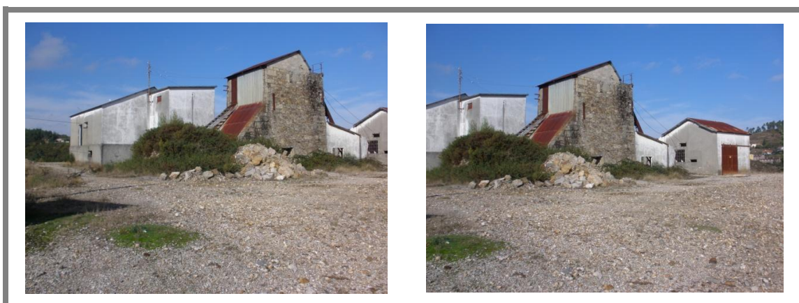
Figura 25 - Casa do guincho do cavalete, casa do skip e casa do guincho do skip.
