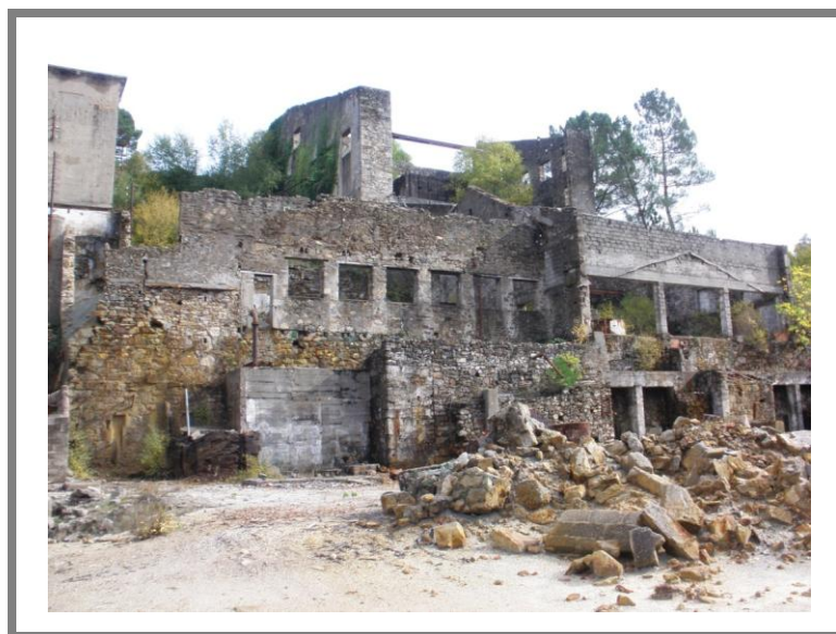
Figura 18 – Antiga afinagem no estado actual.
