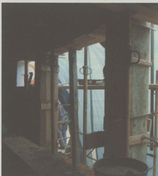
Demolições para instalação de porta e janela
