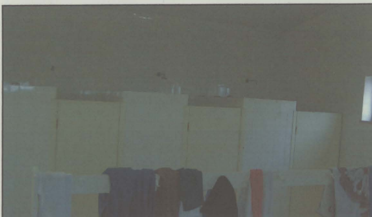
Edifício de Balneários – Zona de Banhos / Cabines de chuveiro
