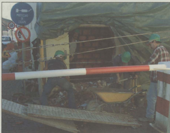
Demolições para instalação de porta e janela
