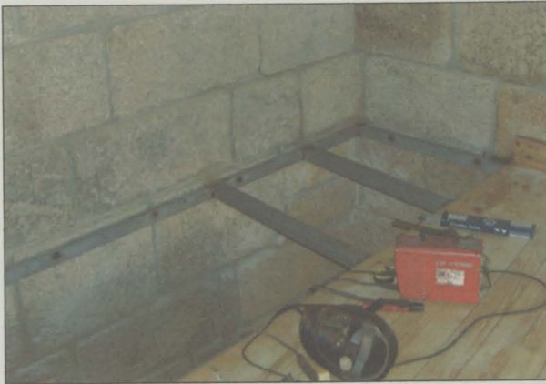
Execução da estrutura metálica de suporte do pavimento em vidro estrutural
