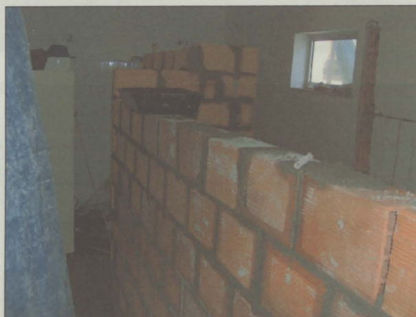
Execução de parede divisória
