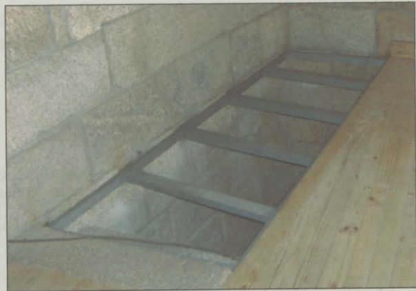
Execução da estrutura metálica de suporte do pavimento em vidro estrutural
