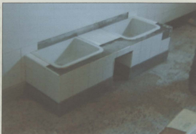
Zona de Banhos – Colocação de azulejo na parede divisória e execução de lava-pés
