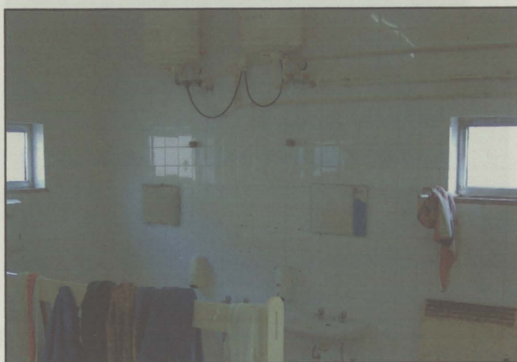
Edifício de Balneários – Zona de Banhos / Posicionamento inicial dos termoacumuladores
