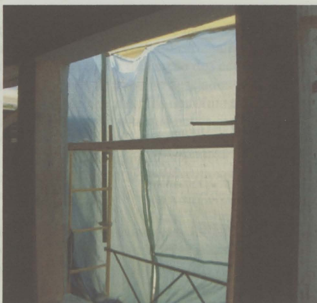
Execução de pilaretes e padieira
