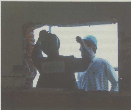
Demolições para instalação de porta e janela
