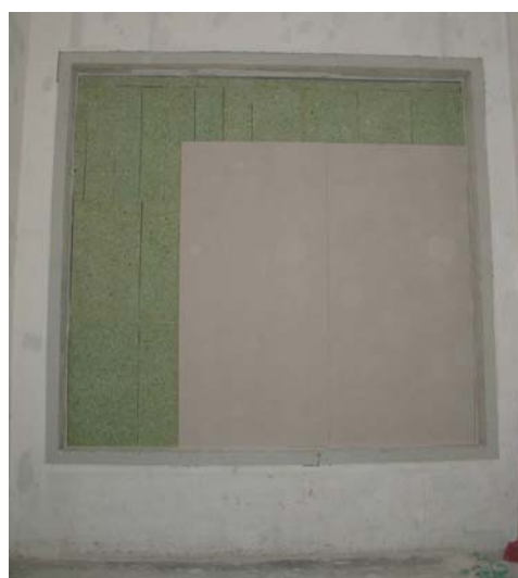
Figura 4.8 - Pormenor da colagem das placas de gesso para a construção tipo 4
