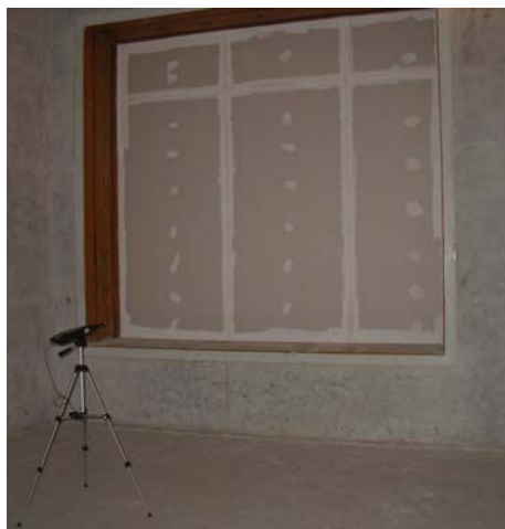
Figura 4.2 – Construções tipo 1 e 2 montadas na câmara reverberante
