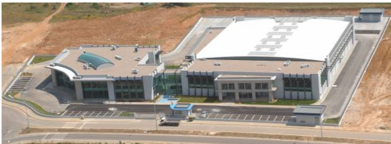
Fig. 1 – Instalações da Lismolde 2, Lda.
