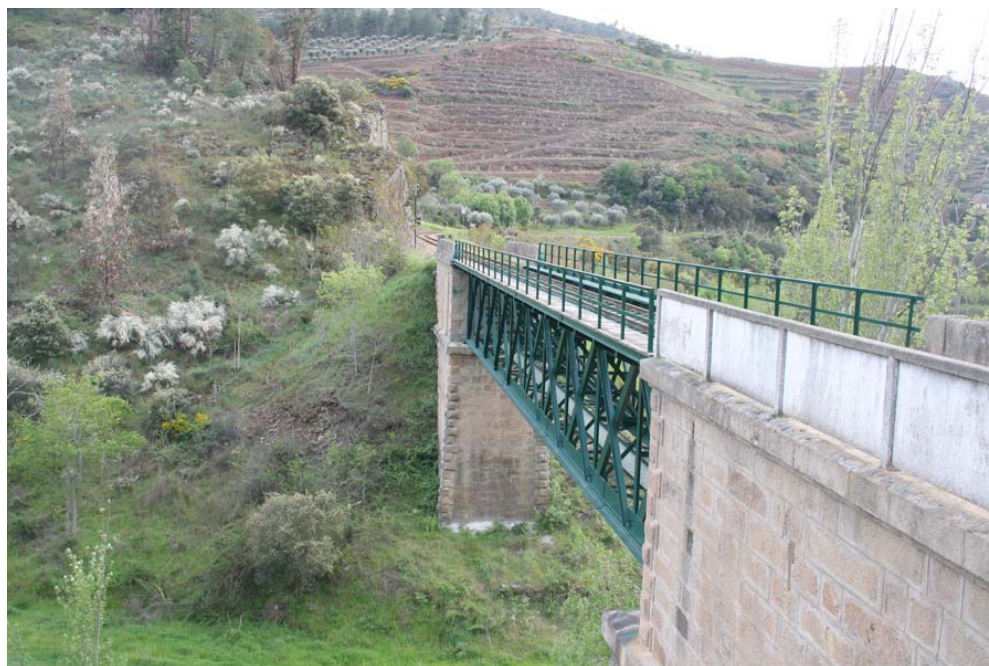
Figura 4.13 – Ponte do Vieiro, Pk 29+200 (fotografia do autor)
