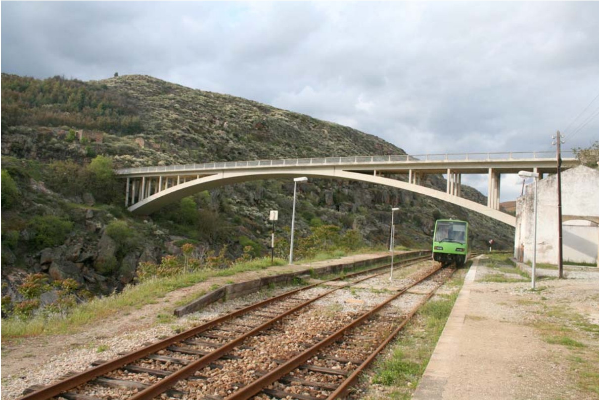
Figura 2.7 – Ponte de Abreiro (fotografia do autor)
