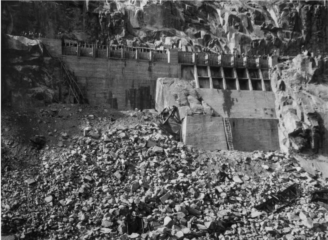
Figura 6.19 – Viaduto das Fragas Más – vista geral da estrutura em fase de construção (fonte: REFER)
