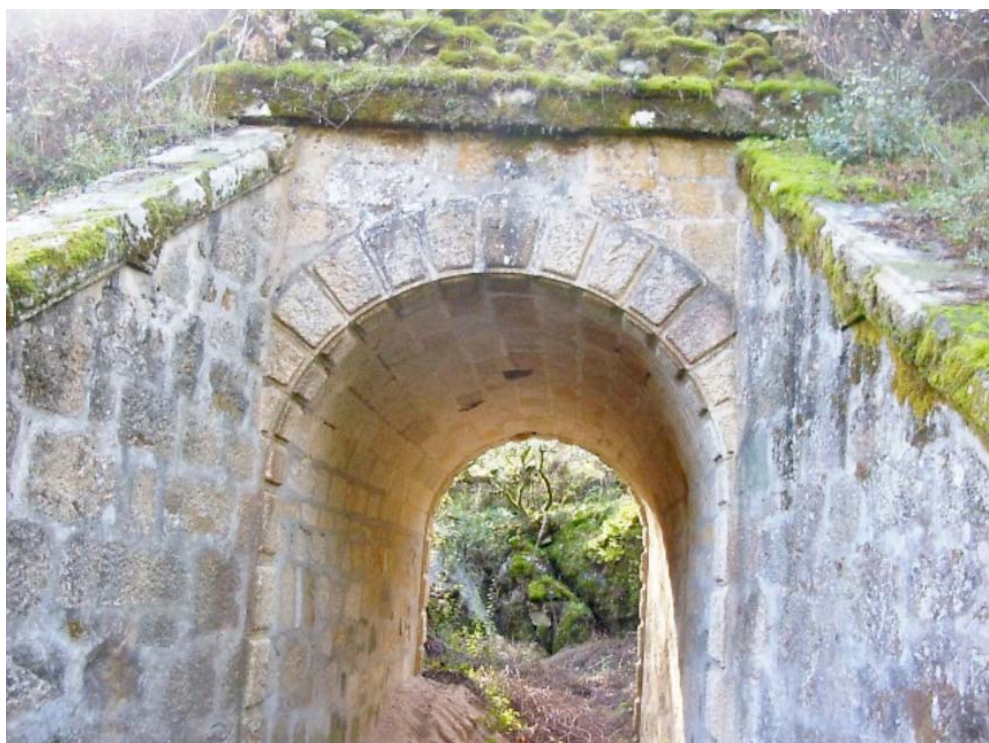
Figura 4.7 – Pontão de Leiras, Pk 17+064 (fonte: REFER)
