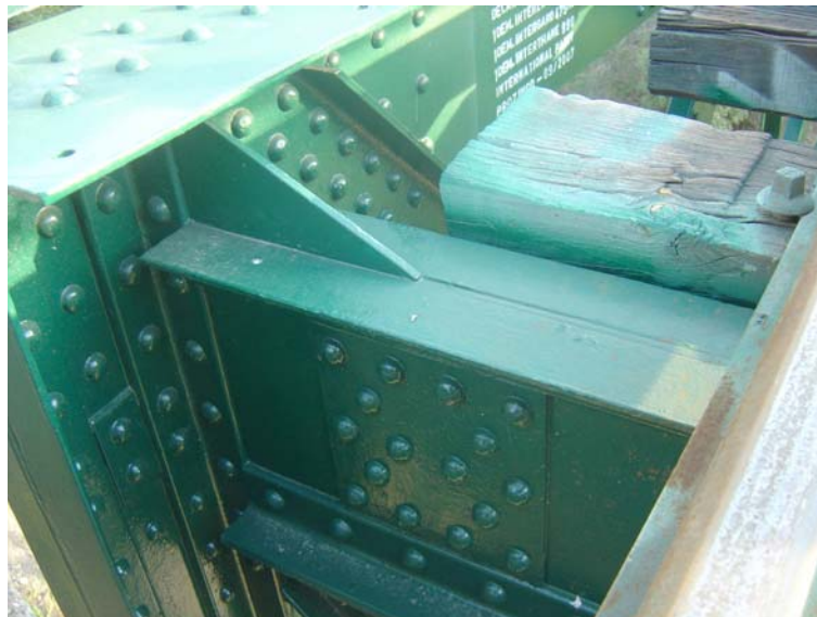
Figura 4.57 – Rebites e chapas de ligação (foto do autor)
