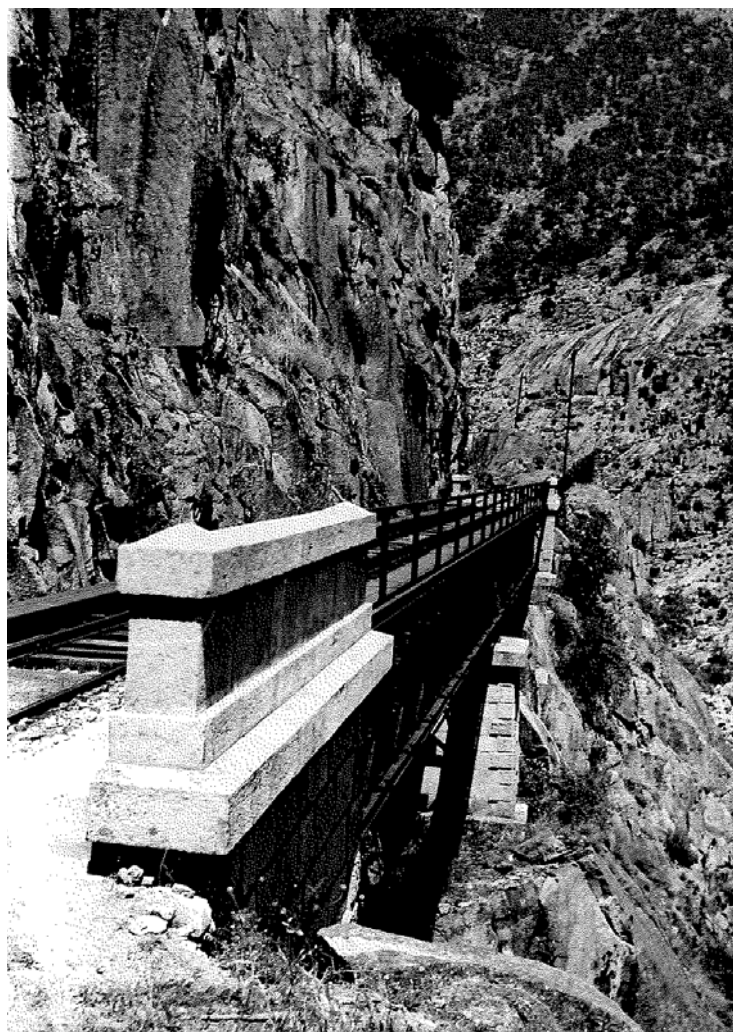
Figura 6.1 – Viaduto das Fragas Más original (fonte: REFER)
