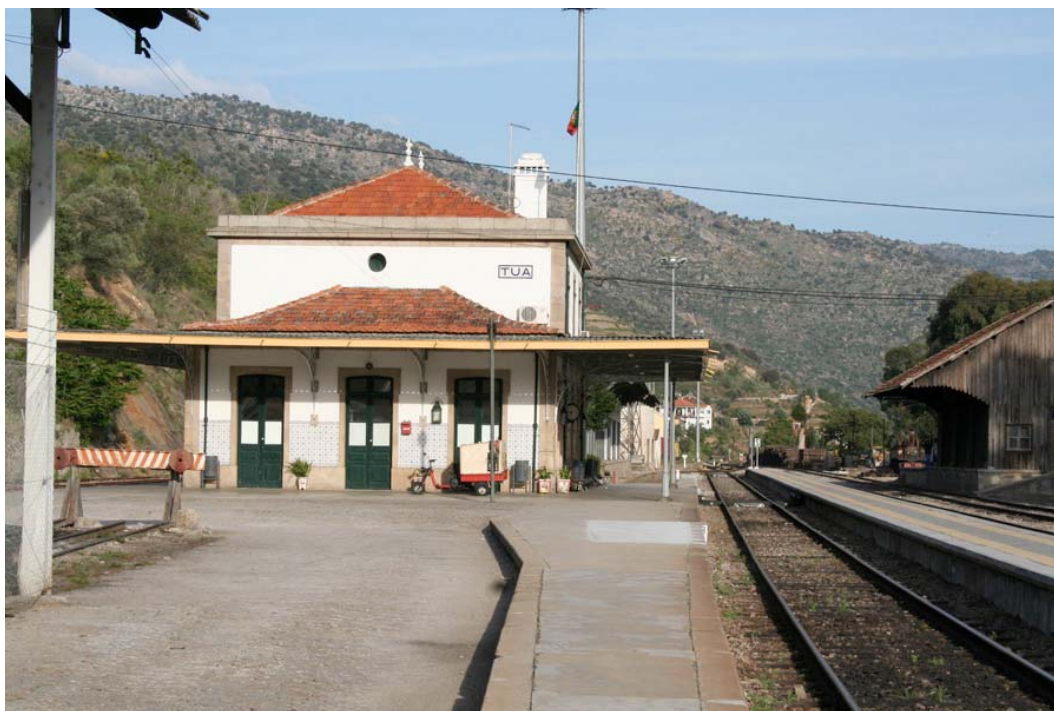
Figura 4.35 – Estação do Tua, Pk 0+000 (fotografia do autor)
