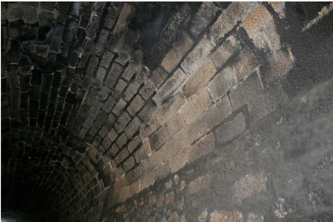
Figura 5.10 – Túnel com acabamento interior (fotografia do autor)
