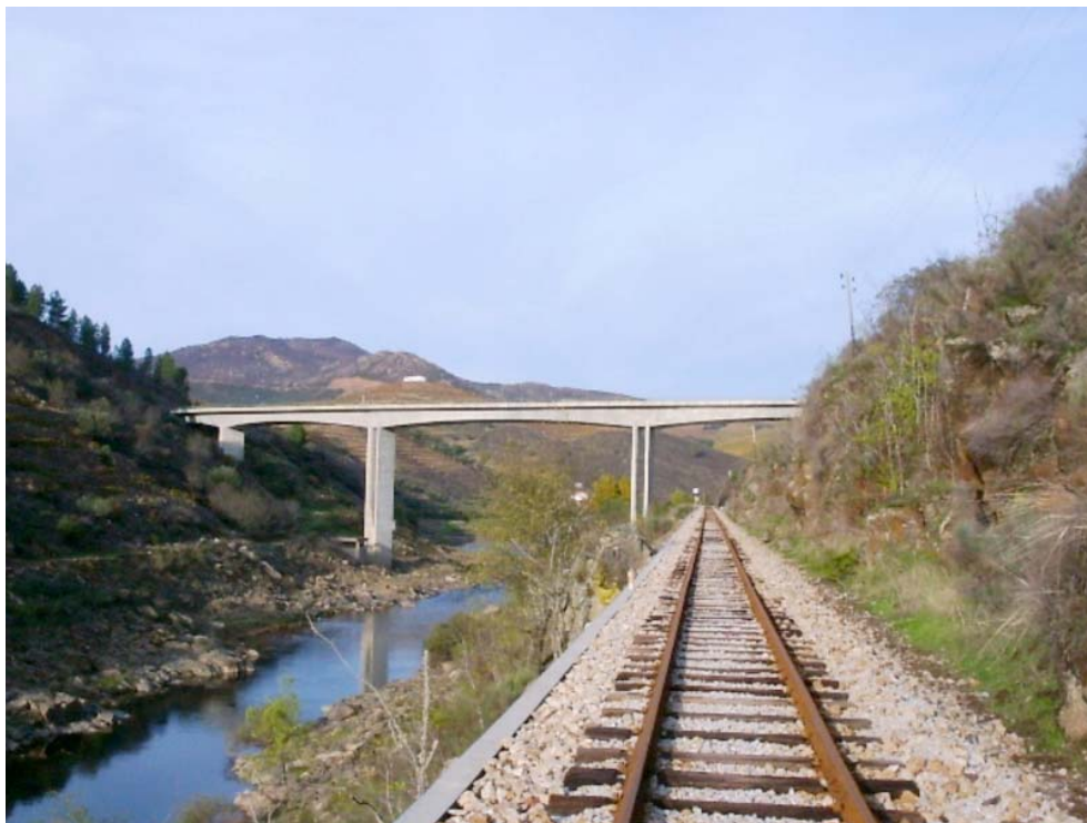
Figura 4.11 – Ponte da Brunheda – passagem superior em betão armado pré-esforçado, Pk 20+924 (fonte: REFER)
