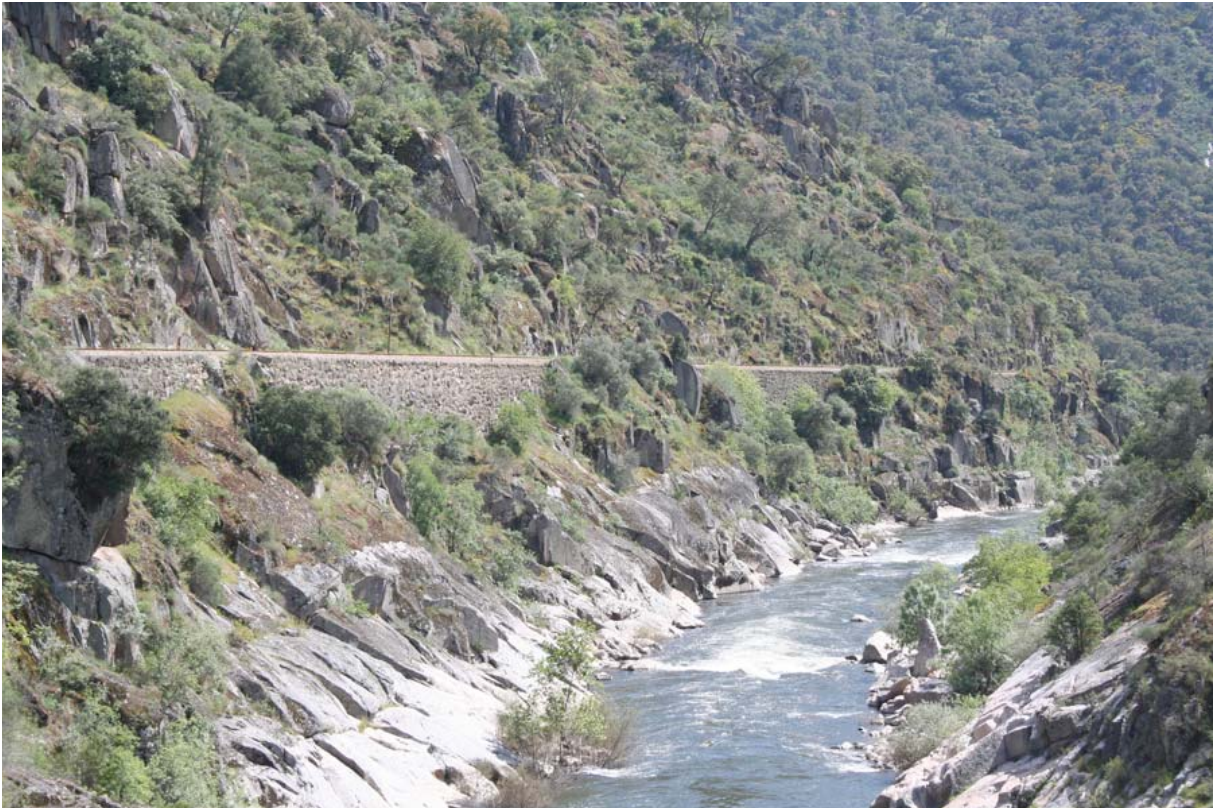
Figura 2.4 – Um dos vários muros de suporte existentes ao longo do traçado (fotografia do autor)
