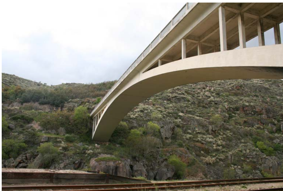
Figura 4.14 – Ponte de Abreiro – passagem superior em betão armado pré-esforçado, Pk 29+332 (fotografia do autor)
