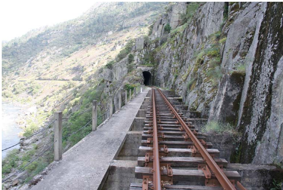
Figura 4.4 – Viaduto das Fragas Más, Pk 5+800 (fotografia do autor)
