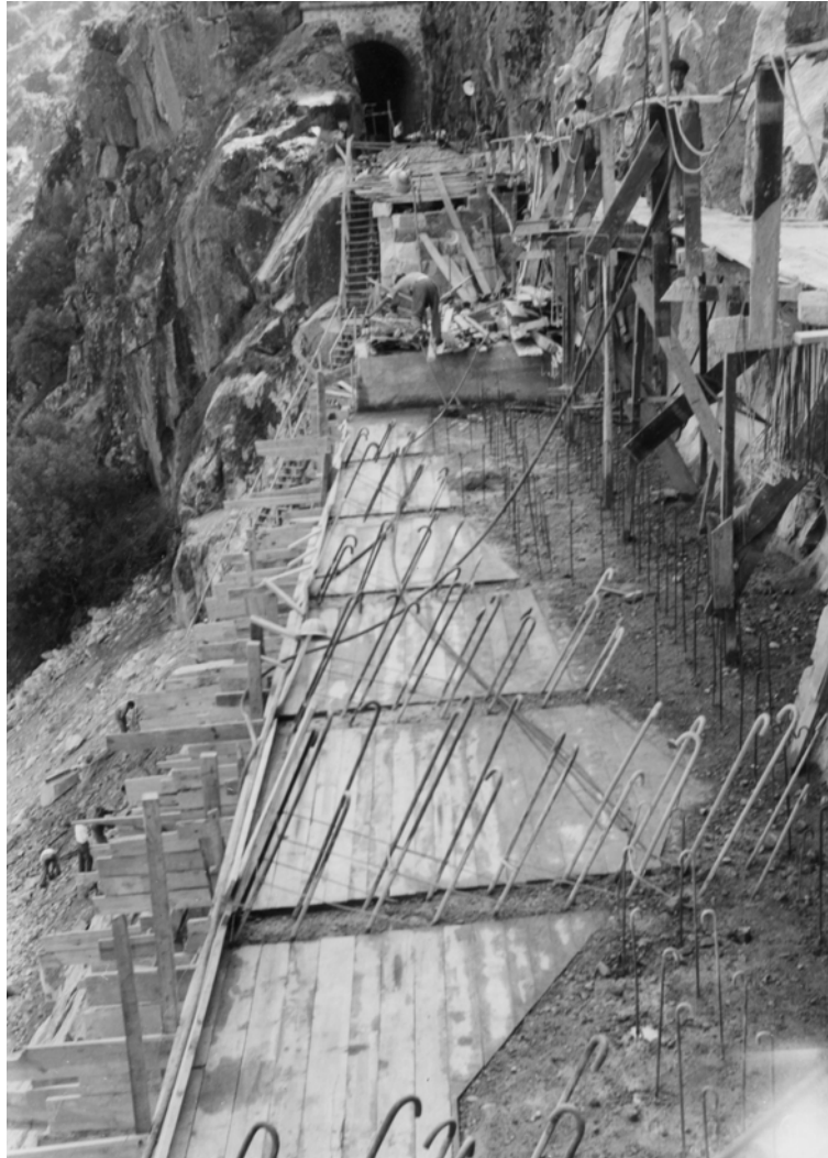
Figura 6.14 – Viaduto das Fragas Más – cofragem da laje de travação e apoio da estrutura celular no tramo de Foz Tua – armaduras dos contrafortes (fonte: REFER)
