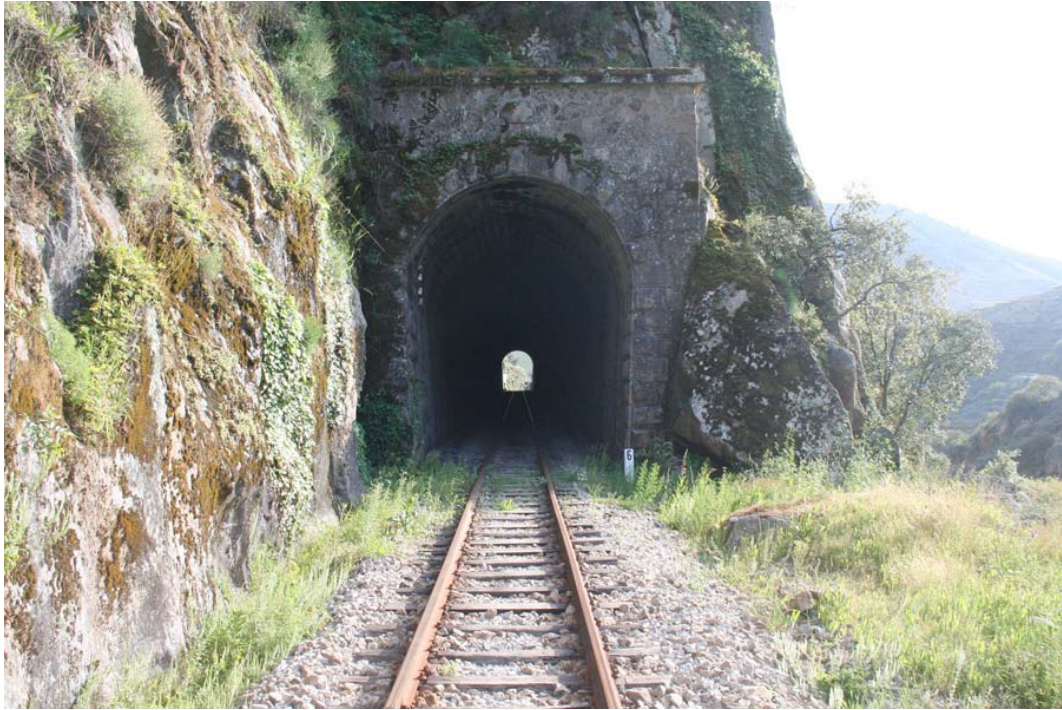
Figura 4.22 – Túnel das Prezas, Pk 1+529 (fotografia do autor)
