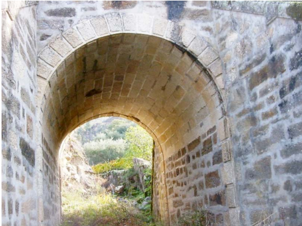
Figura 4.8 – Pontão da Ferrada, Pk 17+311 (fonte: REFER)
