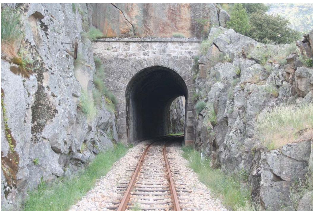
Figura 4.25 – Túnel das Fragas Más II, Pk 5+863 (fotografia do autor)
