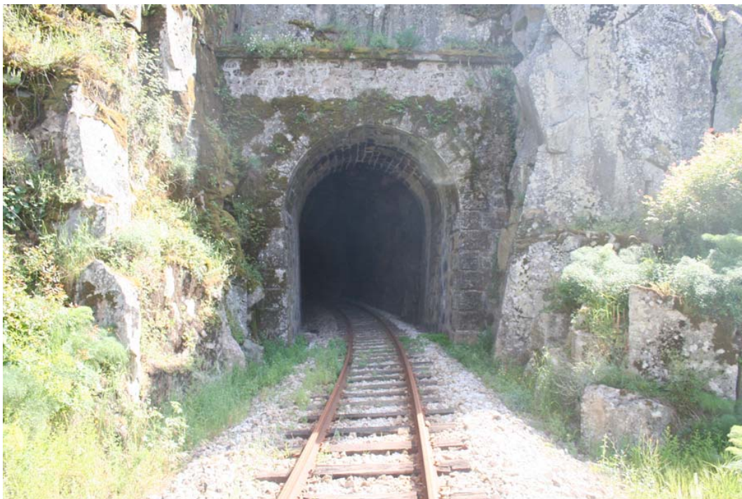
Figura 4.26 – Túnel do Falcoeiro, Pk 9+292 (fotografia do autor)
