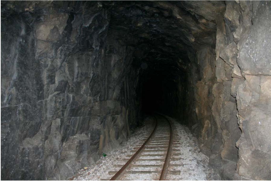
Figura 5.9 – Túnel sem revestimento interior (fotografia do autor)
