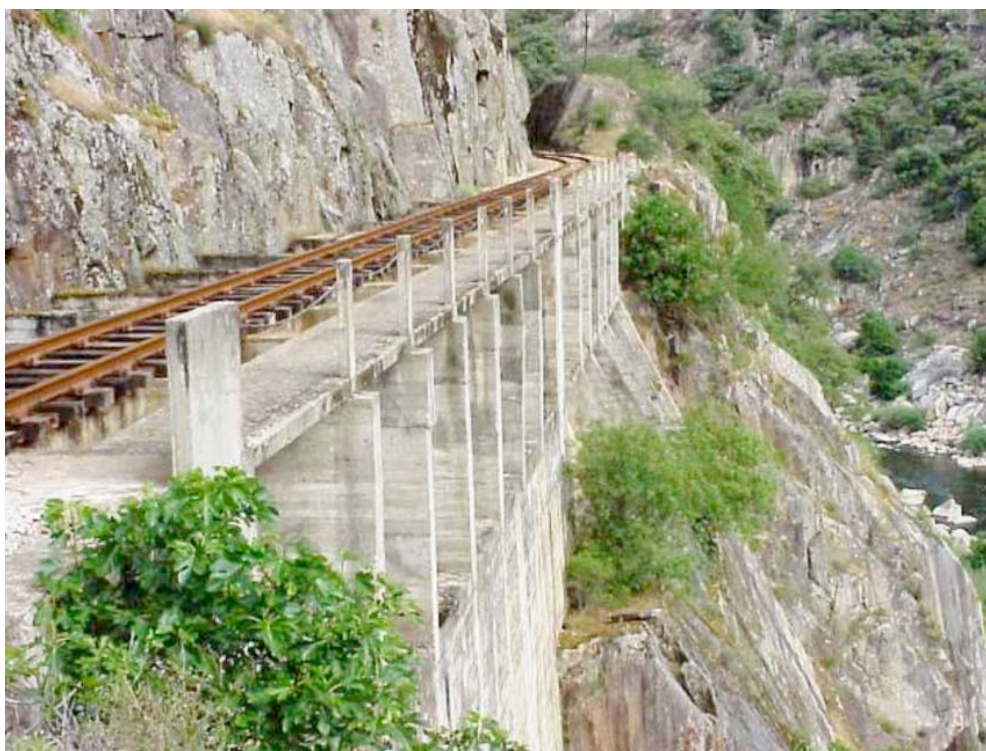
Figura 4.5 – Viaduto das Fragas Más, Pk 5+800 – vista lateral (fonte: REFER)
