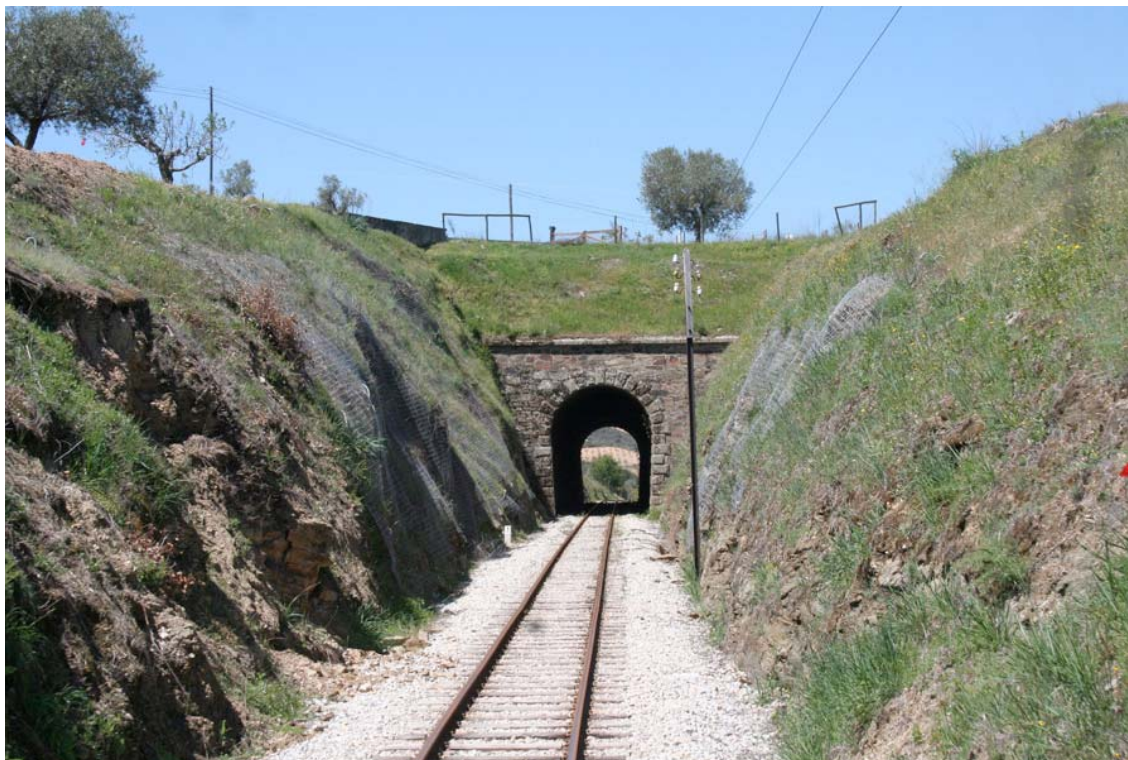
Figura 5.8 – Túnel de Frechas (fotografia do autor)
