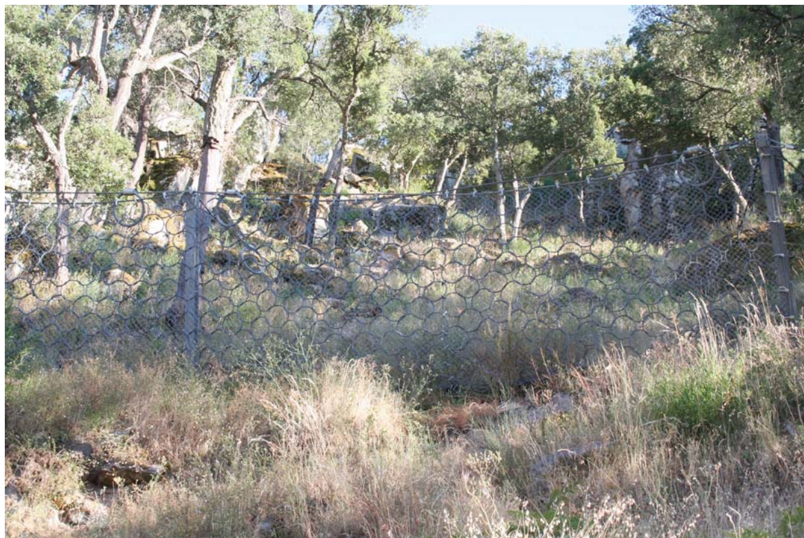
Figura 7.6 – Rede para controlo de queda de pedras (fotografia do autor)
