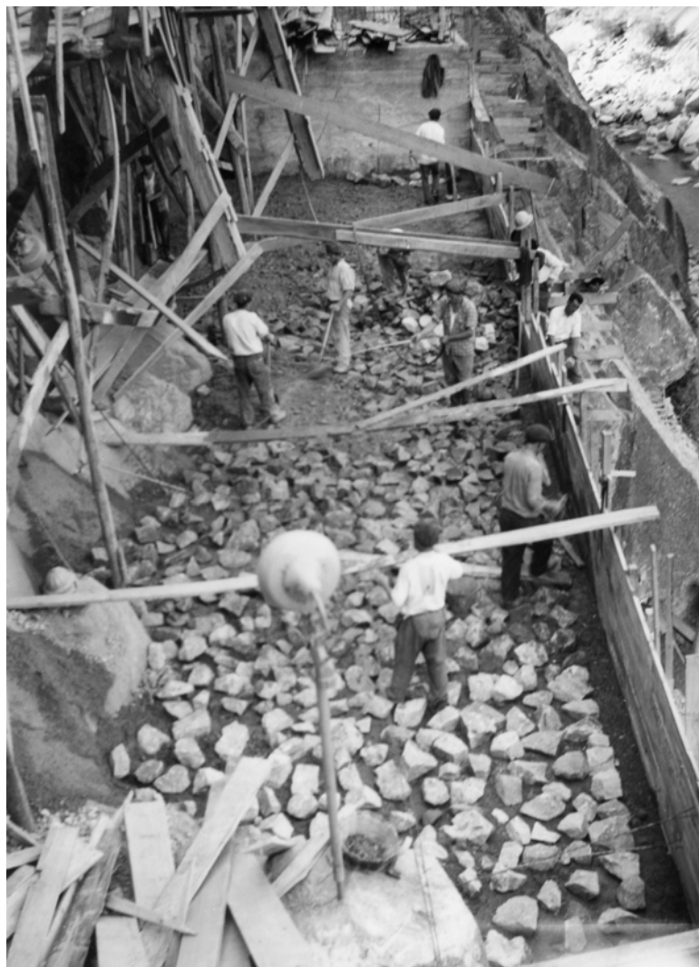
Figura 6.13 – Viaduto das Fragas Más – betão ciclópico no tramo do lado de Mirandela (fonte: REFER)
