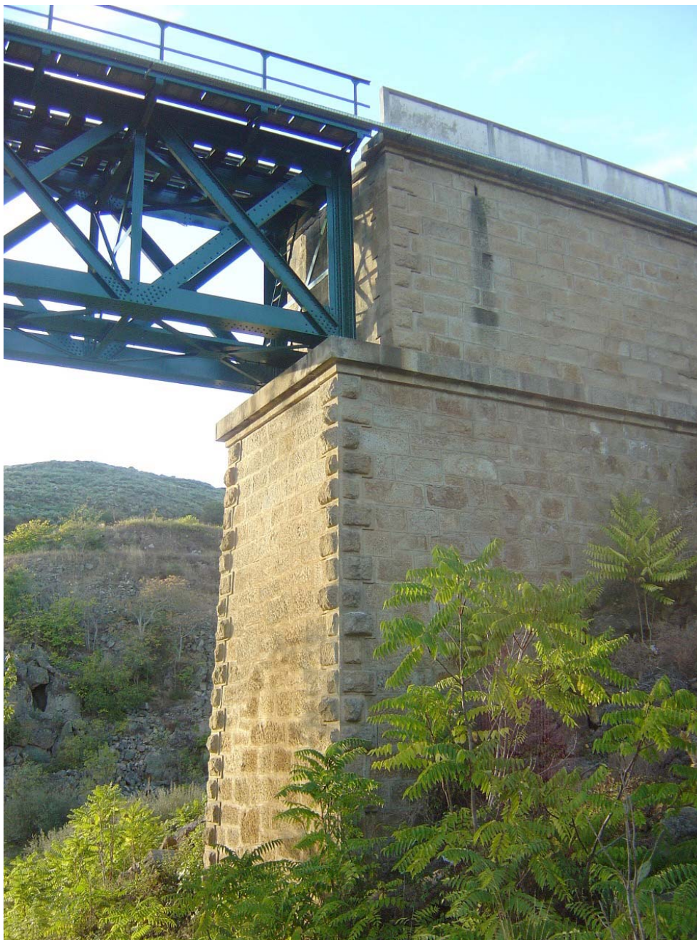
Figura 4.54 – Ponte metálica de 35,0 m de vão – encontro (fotografia do autor)
