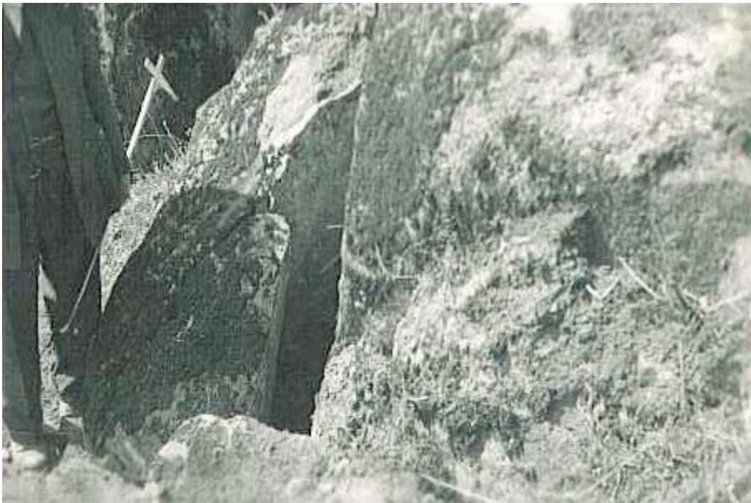
Figura 6.4 – Diaclasamento do maciço (fonte: REFER)
