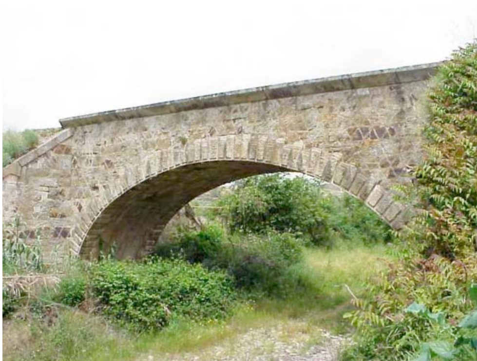
Figura 4.19 – Ponte Ribeira da Carvalha, Pk 45+778 – vista lateral (fonte: REFER)
