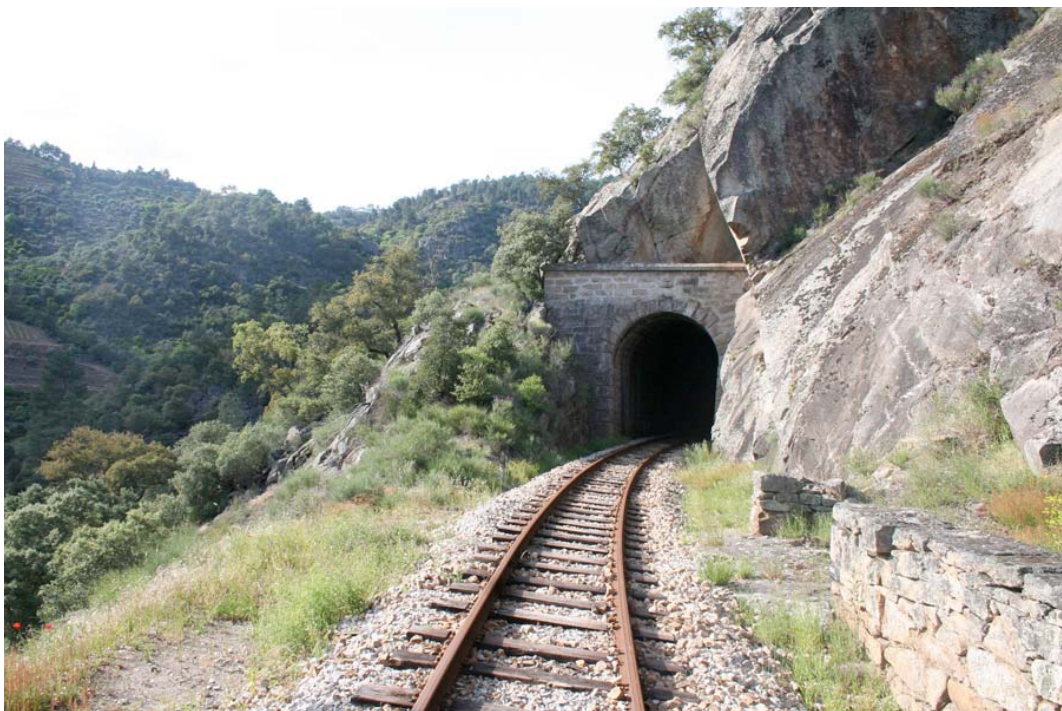
Figura 4.23 – Túnel de Tralhariz, Pk 4+467 (fotografia do autor)
