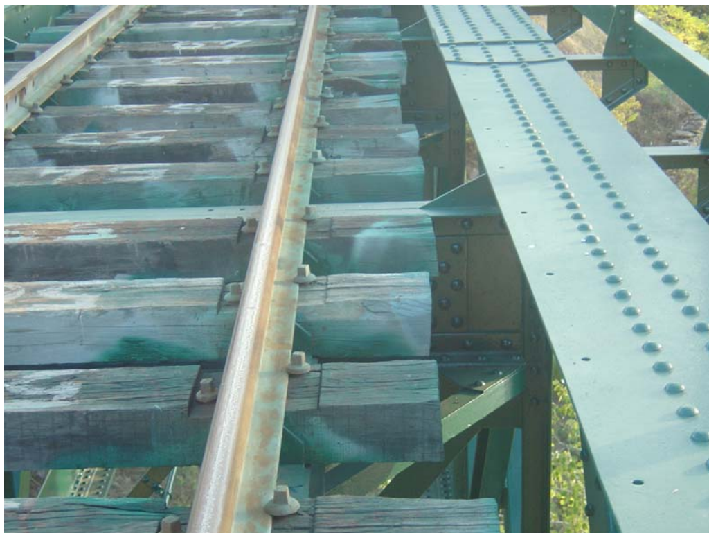
Figura 4.49 – Ponte metálica com 35,0 m de vão – carris (fotografia do autor)
