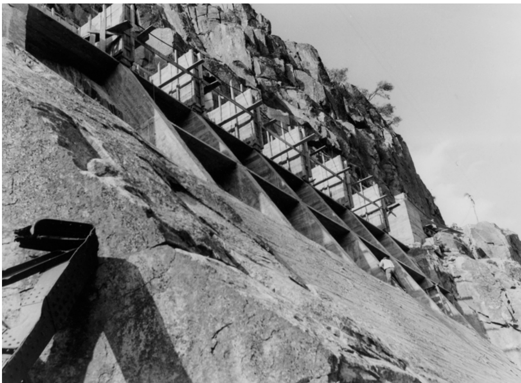
Figura 6.15 – Viaduto das Fragas Más – contrafortes contraventados no tramo do lado da Foz do Tua (fonte: REFER)
