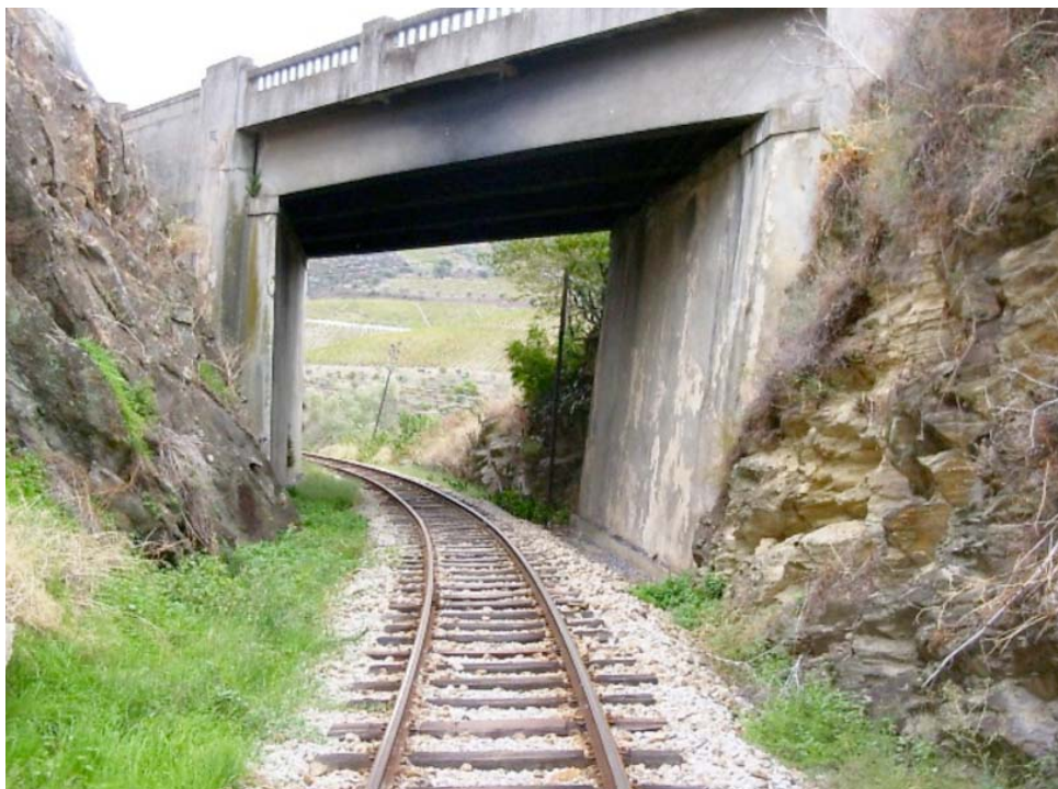
Figura 4.1 – Passagem superior em betão armado, Pk 0+807 (fonte: REFER)
