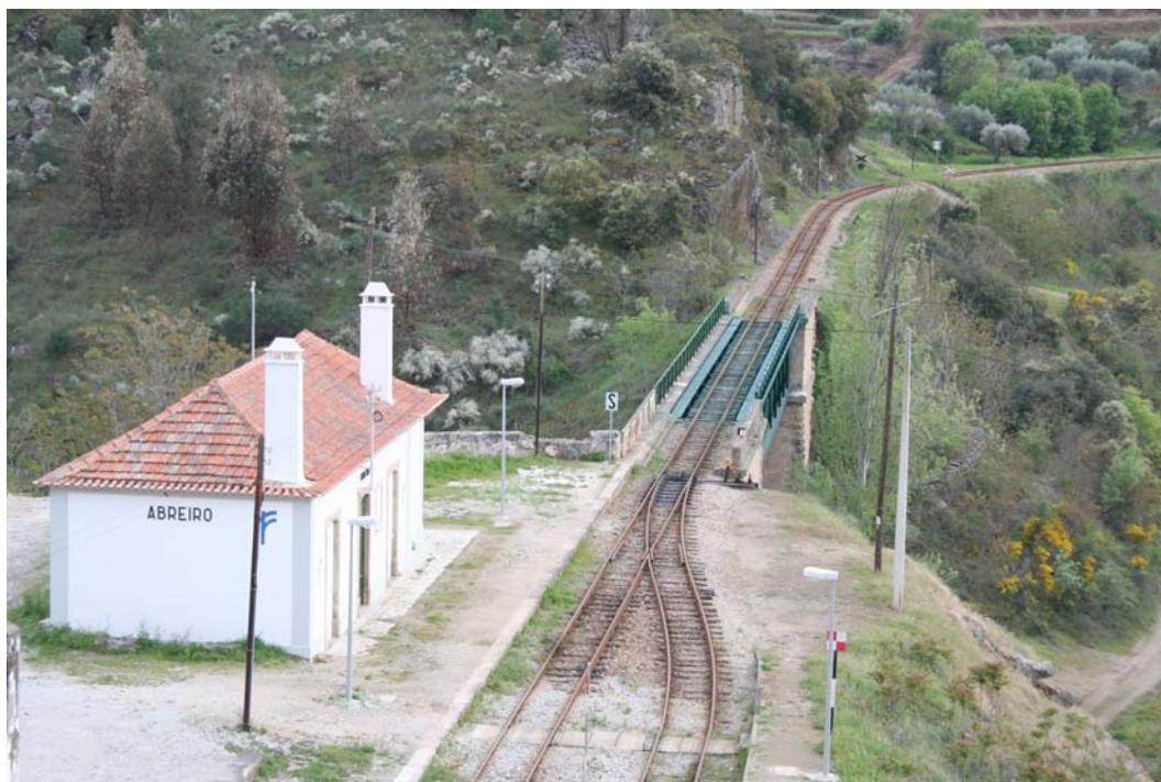
Figura 4.37 – Estação de Abreiro, Pk 29+253 (fotografia do autor)
