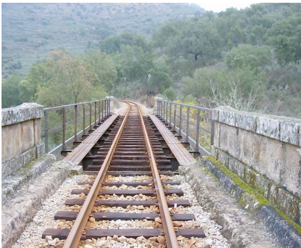
Figura 4.12 – Ponte de Cabreira, Pk 26+642 (fonte: REFER)
