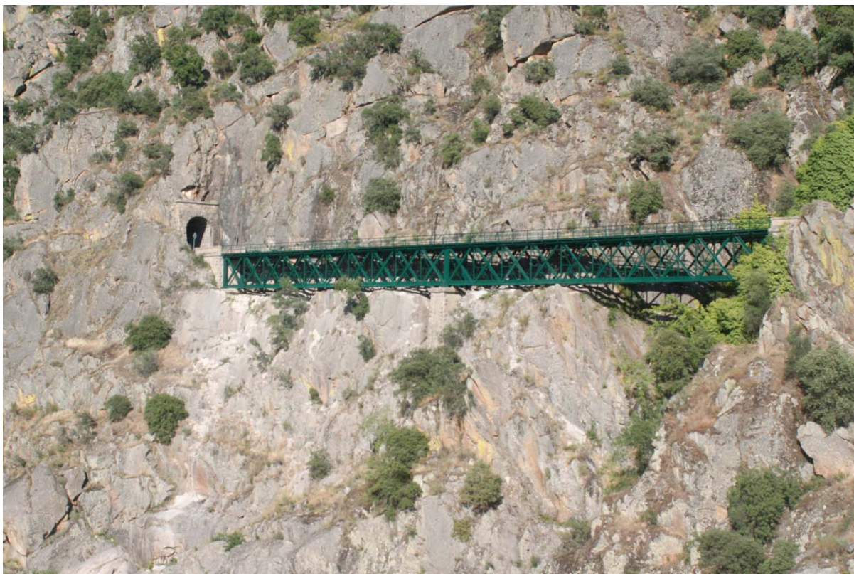
Figura 2.3 – Viaduto das Prezas (fotografia do autor)
