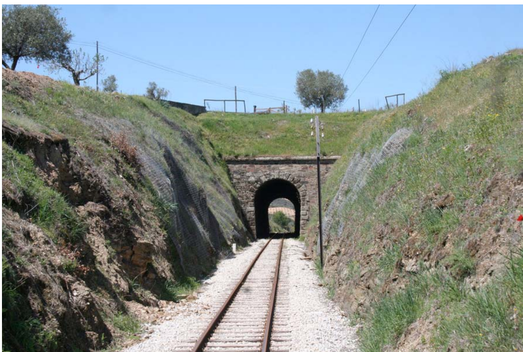
Figura 4.27 – Túnel de Frechas, Pk 46+170 (fotografia do autor)
