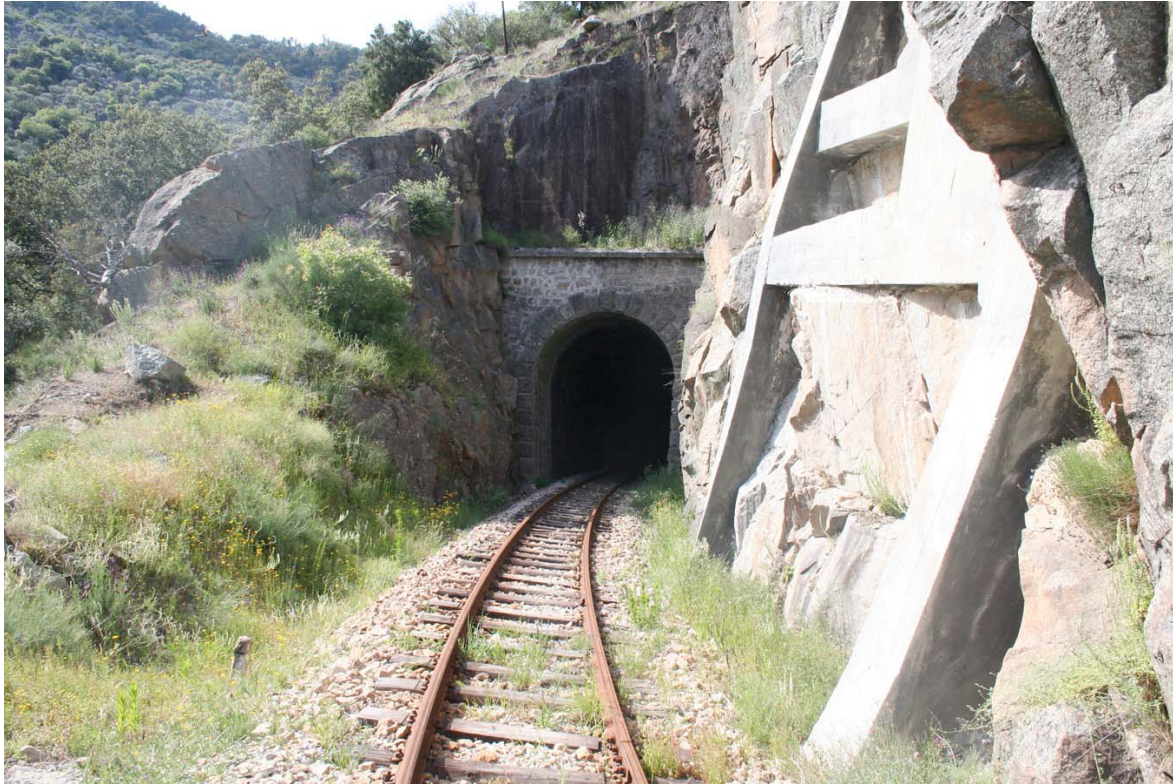
Figura 7.4 – Contenção de bloco rochoso (fotografia do autor)
