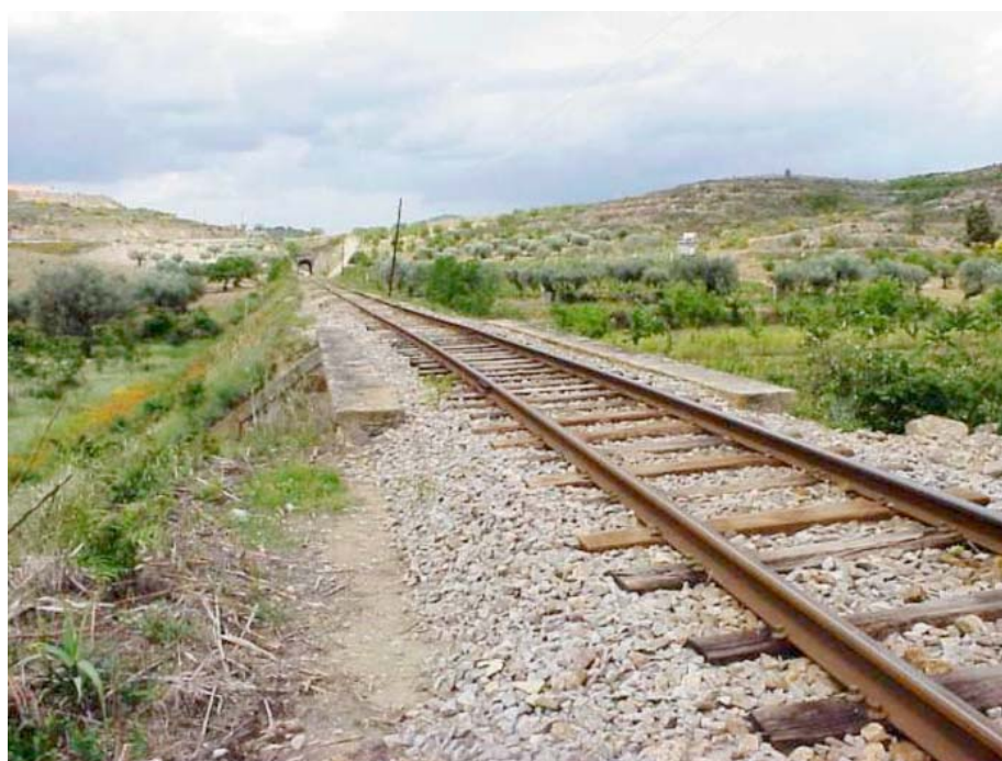
Figura 4.18 – Ponte Ribeira da Carvalho, Pk 45+778 (fonte: REFER)
