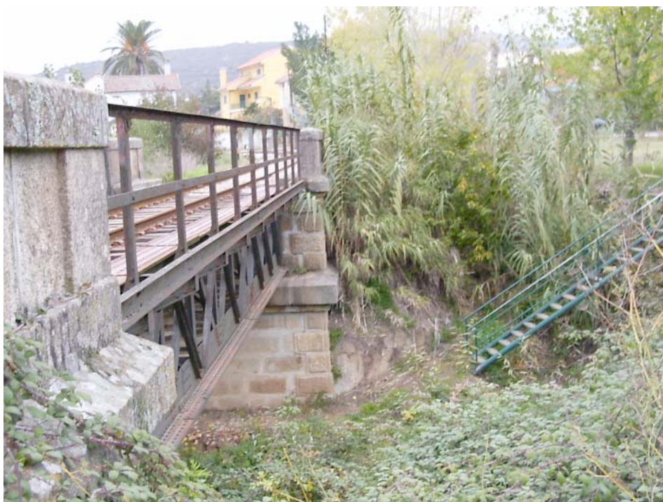
Figura 4.16 – Ponte de Meireles, Pk 41+741 (fonte: REFER)
