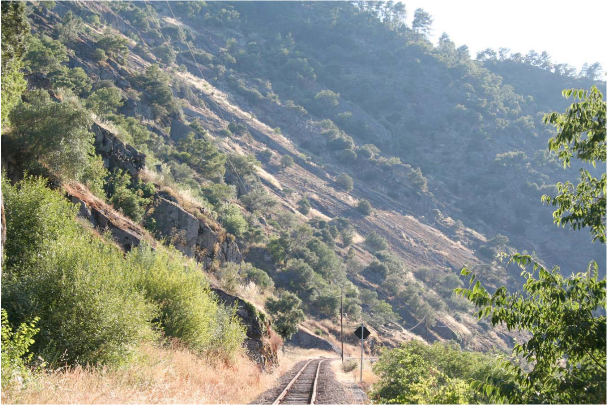
Figura 7.10 – Encosta com zona de potencial deslizamento planar (fotografia do autor)
