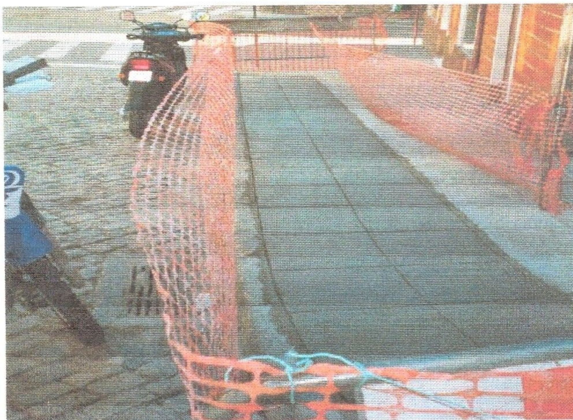
Figura 6 – Reposição de pavimentos
