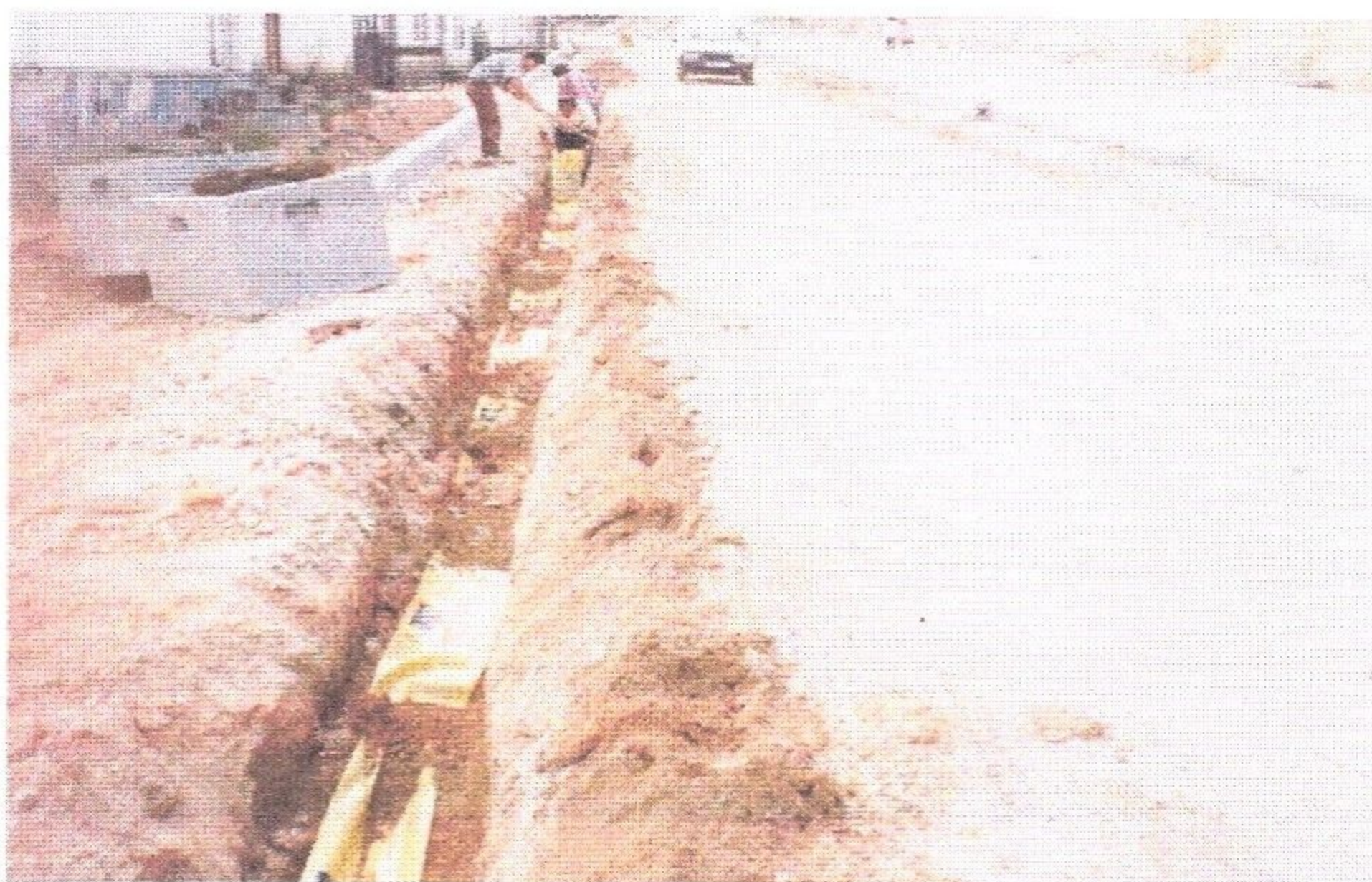
Figura 9 – Colocação da fita de sinalização
