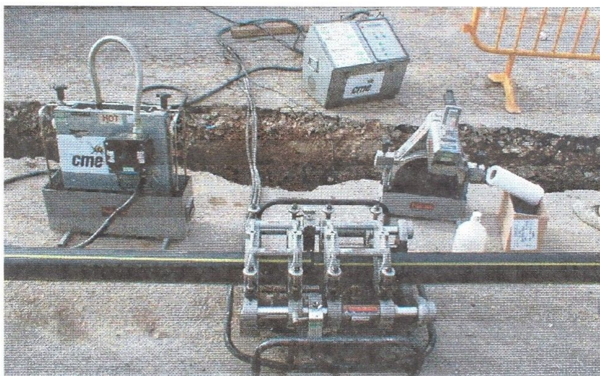
Figura 4 – Soldadura topo a topo em obra de uma tubagem em polietileno
