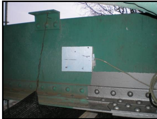
Figura 3.13 – Placa de isolamento térmico sobre um sensor de temperatura
