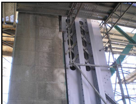
Figura 4.21 – Beneficiação do montante junto a um dos encontros
