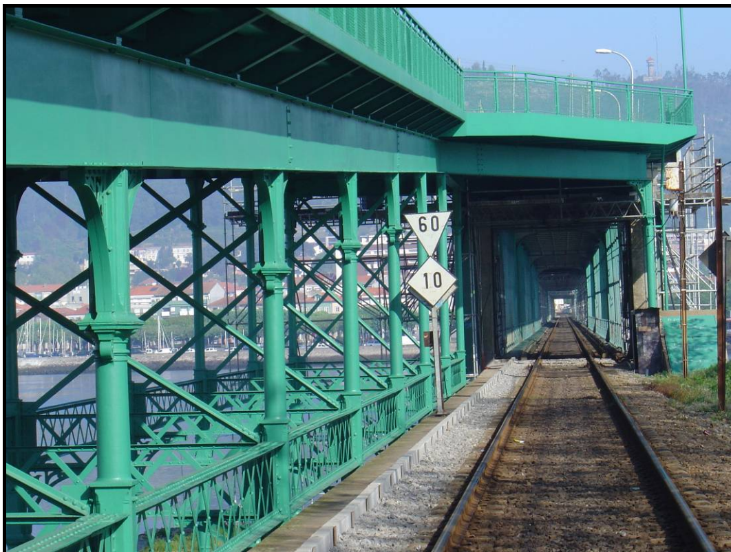
Figura 4.2 – Vista geral do Viaduto de acesso na margem Sul
