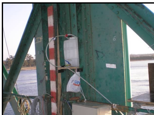
Figura 5.36 – Reservatório no pilar P5
