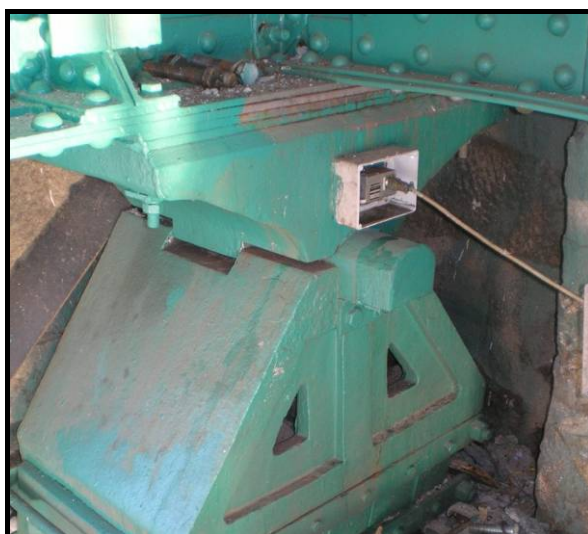
Figura 5.43 – Fixação dos inclinómetros junto aos aparelhos de apoio
