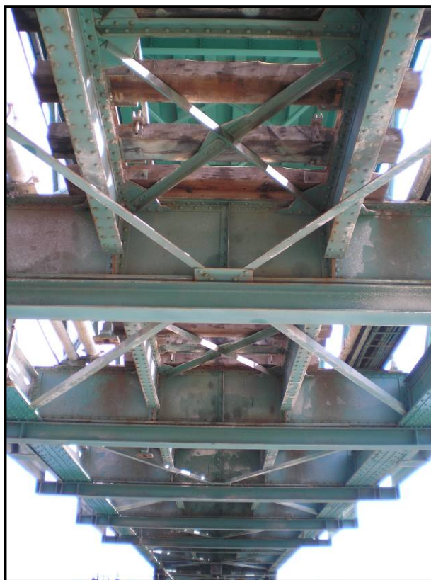
Figura 4.6 – Vista do tabuleiro inferior
