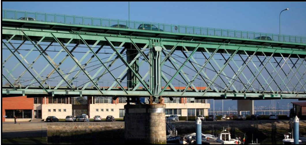
Figura 4.7 – A solução de reforço através da aplicação de pré-esforço exterior
