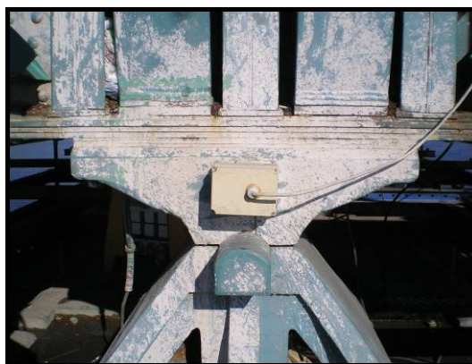
Figura 5.2 – Inclinómetro no aparelho de apoio
