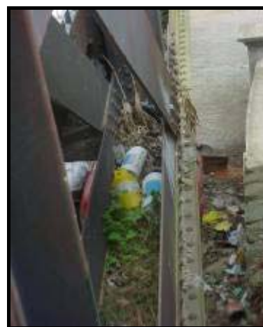
Figura 2.10 - Banzo em forma de "U" com acumulação de detritos [10]
