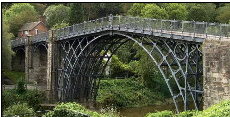
Figura 2.1 – Vista da Ponte de Coalbrookdale [8]
