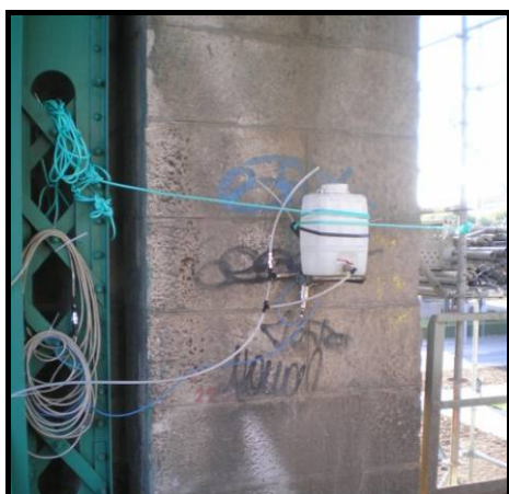
Figura 5.35 – Reservatório no Encontro E2
