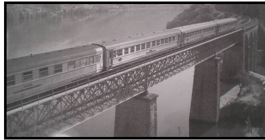
Figura 2.6 – Ponte de Murça (Viga principal do tipo rótula múltipla)
