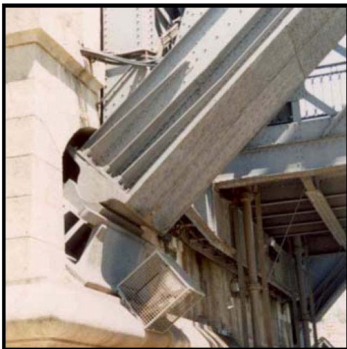
Figura 2.14 – Aparelho de apoio do tipo fixo [17] Figura 2.15 – Aparelho de apoio do tipo móvel [17]
