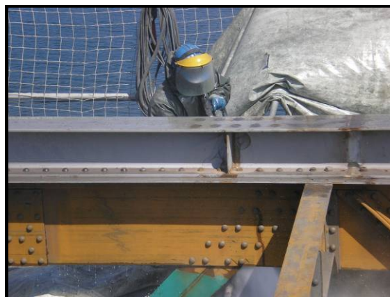
Figura 4.22 – Hidrodecapagem
