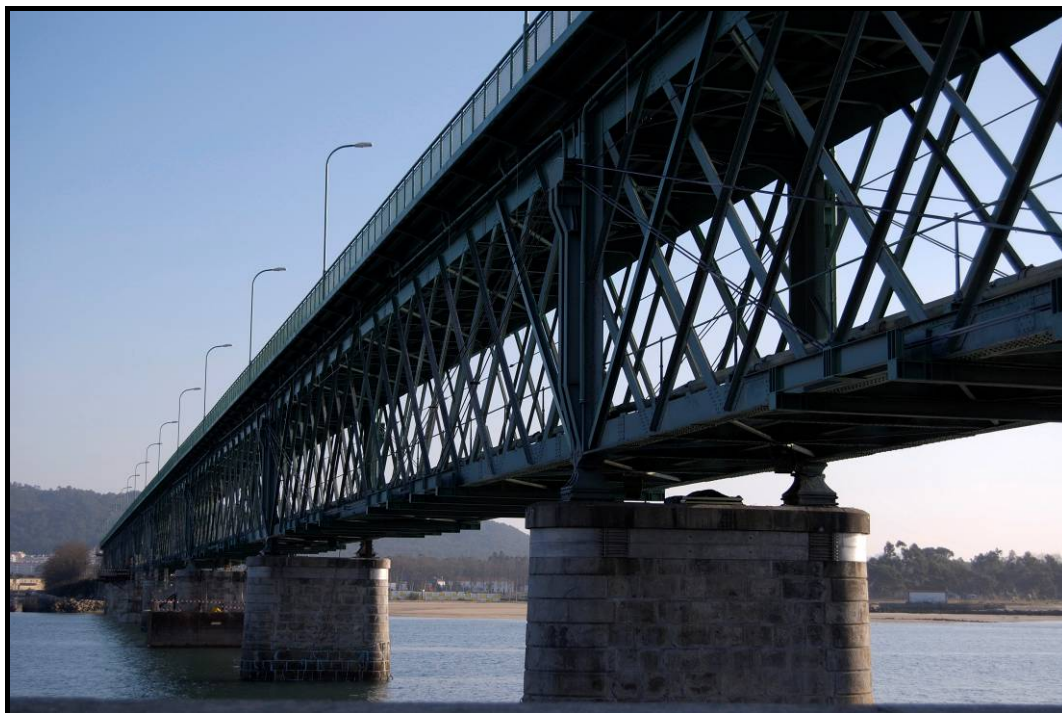
Figura 4.1 – Vista geral da Ponte Eiffel
