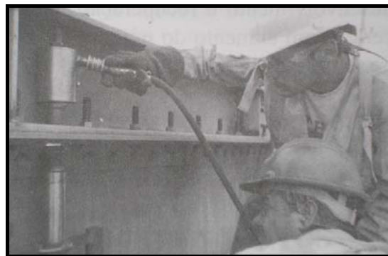
Figura 2.21 Ilustração da actividade do cravador e do responsável pelo encosto [18]
