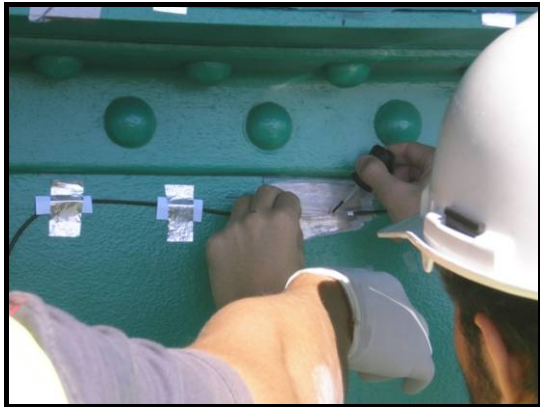
Figura 3.8 – Aplicação de um extensómetro
