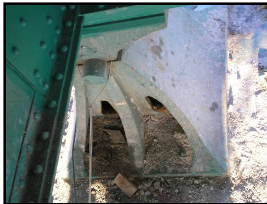
Figura 5.86 – Aparelho de apoio fixo, antigo
