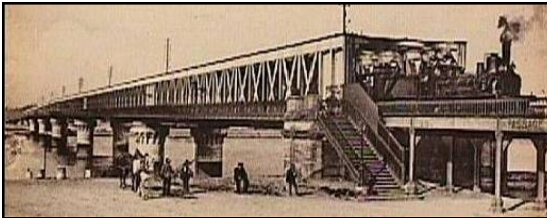
Figura 2.2 – Vista da Ponte La Passerelle [9]
