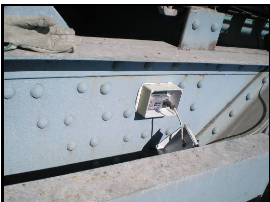
Figura 5.1 – Inclinómetro na corda inferior
