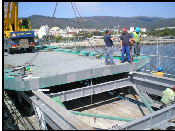
Figura 4.20 – Colocação de um módulo do tabuleiro rodoviário
