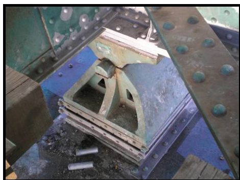
Figura 5.82- Aparelho de apoio móvel, antigo
