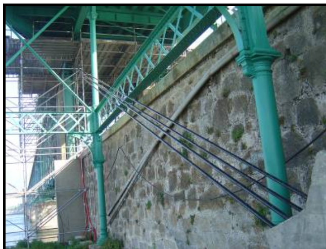
Figura 4.10 – Ancoragem do sistema de pré-esforço
