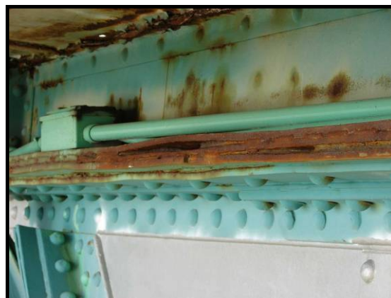
Figura 2.12 – Exemplo de formação de bolsas de ferrugem entre chapas
