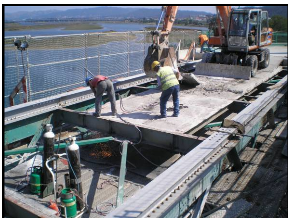
Figura 4.15 – Remoção do pavimento em betão armado
