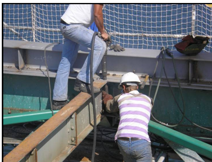
Figura 4.18 – Processo de cravação de rebites
