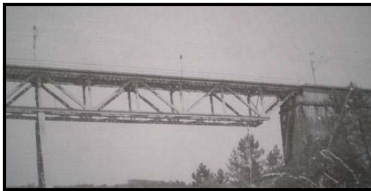
Figura 2.7 – Ponte de Trezói (Viga principal do tipo Warren )
