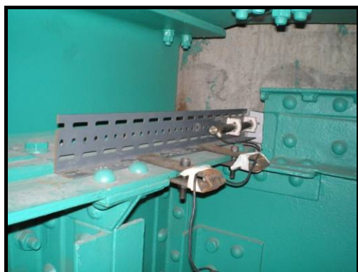
Figura 5.80 – LVDT na Corda Superior
