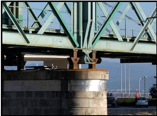
Figura 5.84- Par de escoras, provisórias
