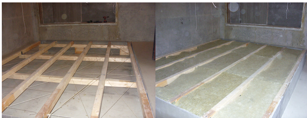
Fig.5.22 – Colocação da lã mineral na caixa-de-ar
