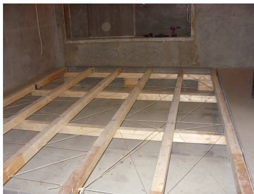
Fig.5.14 – Interior da câmara reverberante R1 com estrutura de madeira para suporte dos painéis
