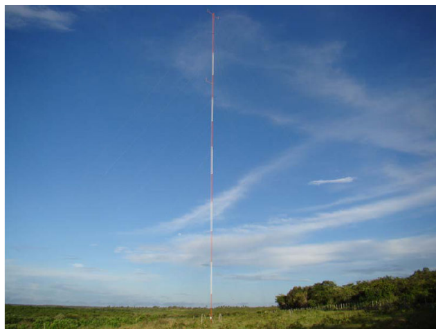
Figura 23 – Exemplo de uma torre anemométrica [15]
