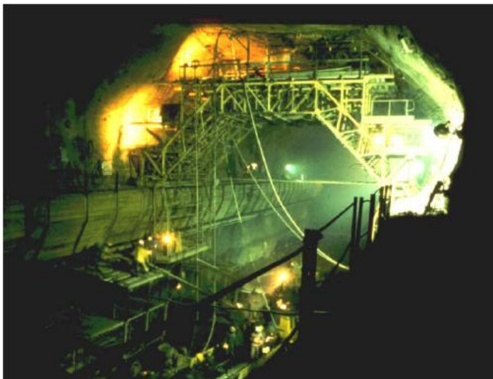
Fig. 3.4 – Grua temporária construída para aceder ao tecto da caverna da central de Drakensberg, na África do Sul [8]
