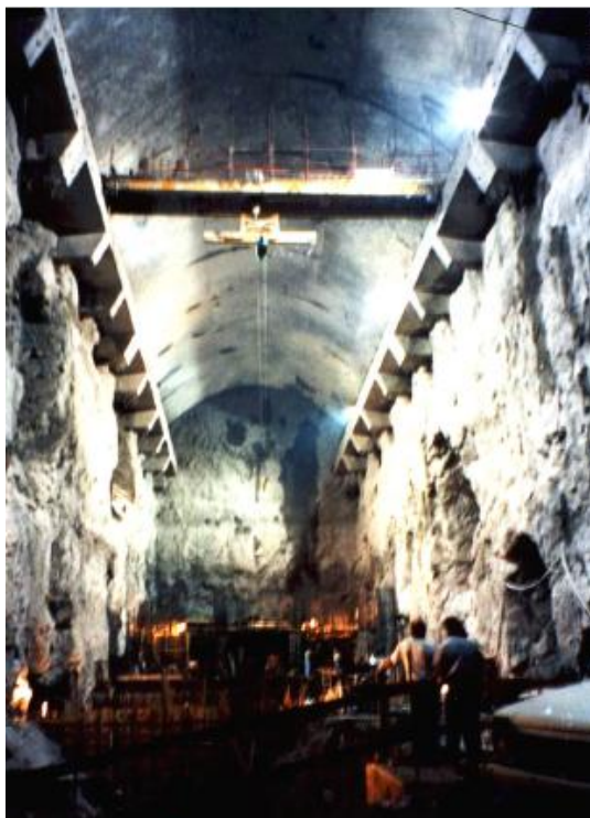
Fig. 2.2 – Fase inicial de construção das vigas de suporte dos caminhos de rolamentos da central de Thissavros, na Grécia [18]
