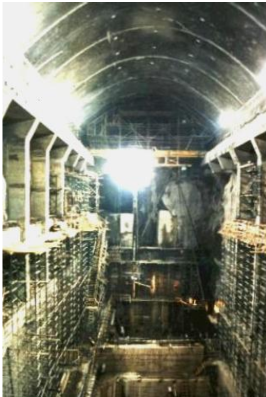
Fig. 2.3 – Construção final das colunas de apoio das vigas de suporte dos caminhos de rolamentos da central de Thissavros [18]
