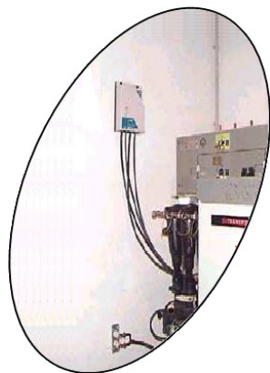
Figura 4.5 - Indicador de Passagem de Defeito instalado no interior de um posto de transformação MT/BT
