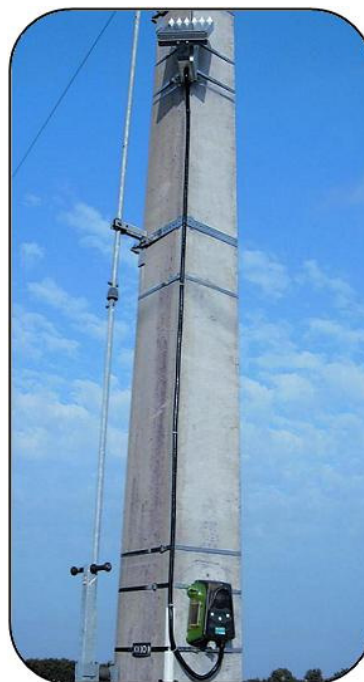
Figura 5.6 - G200 instalado no apoio e alimentado por um painel solar
