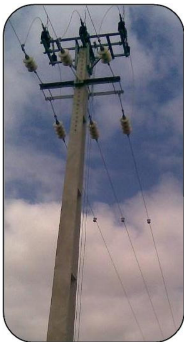
Figura 5.5 - Flite 116-SA instalados nas três fases da linha aérea de média tensão
