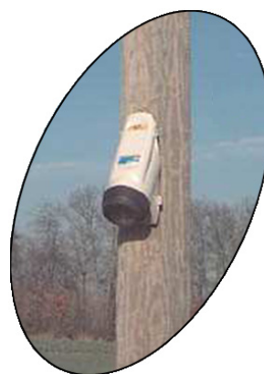
Figura 4.8 - Indicador de Passagem de Defeito trifásico para montagem em poste
