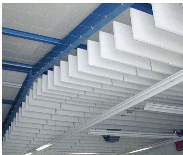
Figura 2.8 - Exemplo de aplicação de absorvedores suspensos ( baffles )
