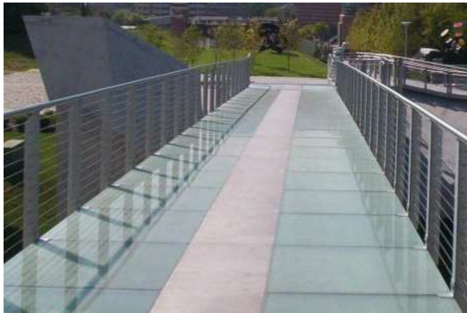
Figura 2.12 - Ponte pedonal no Tennessee, EUA: Exemplo da aplicação do vidro no pavimento de uma ponte pedonal;
