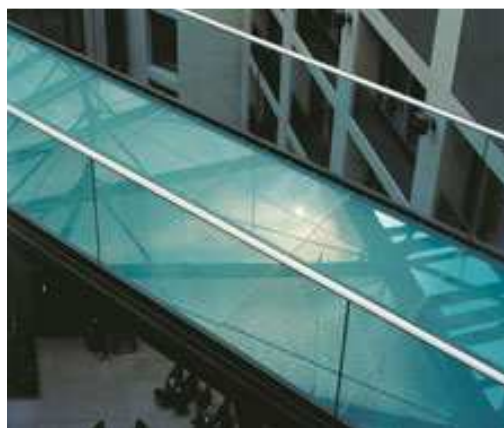
Figura 2.6- Exemplo de aplicação de vidro laminado em guarda-corpos;
