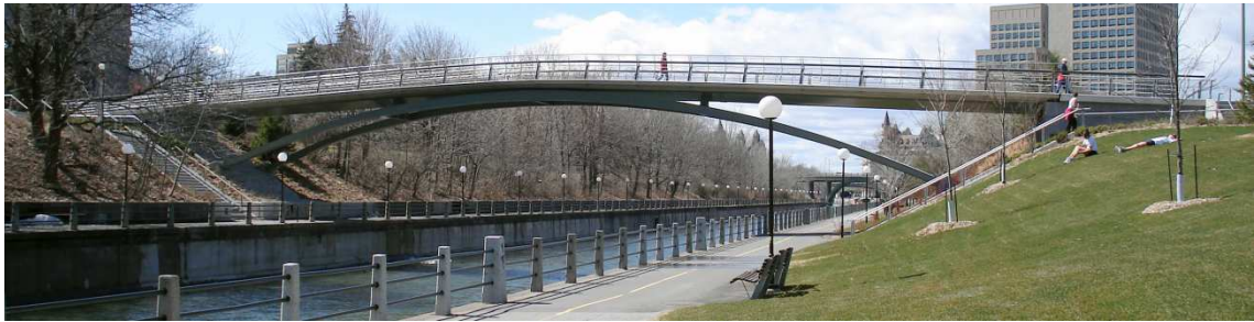
Figura 2.27- Corktown Bridge , Ottawa, Canadá;
