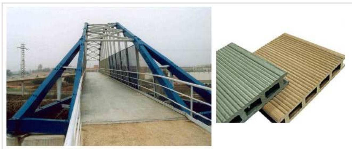
Figura 2.11 - Ponte pedonal em Lleida, Espanha e o tipo de pavimento utilizado;
