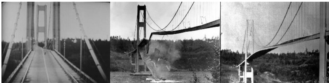
Figura 5.6- Imagens do colapso da Ponte Tacoma;
