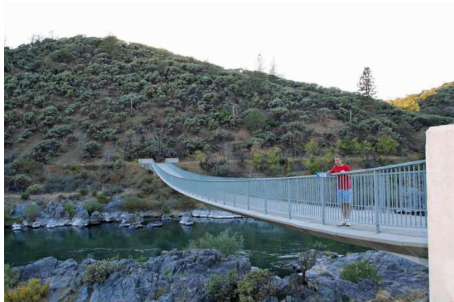
Figura 2.21 -Sacramento River Trail Bridge (EUA): Exemplo de uma ponte do tipo Stress Ribbon;
