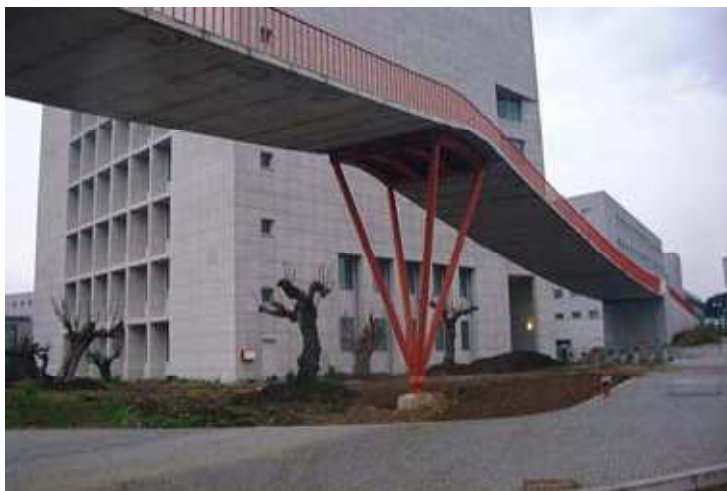
Figura 2.23- Ponte pedonal existente nas proximidades da FEUP, um exemplo de uma ponte do tipo stress ribbon ;
