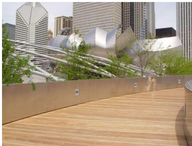
Figura 2.10 - Pavimento em madeira na BP Bridge, Millenium Park, Chicago, EUA;
