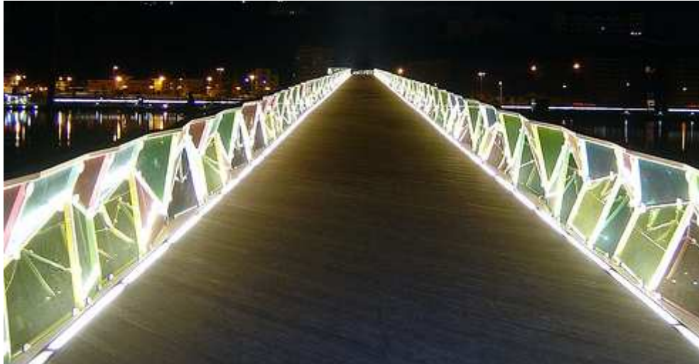
Figura 2.17- Ponte pedonal Pedro e Inês, Coimbra: exemplo de aplicação de cores na iluminação de uma ponte pedonal;
