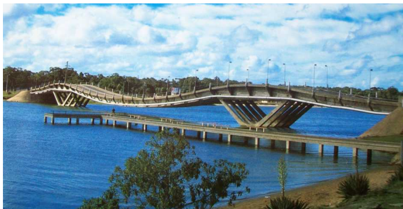
Figura 2.22- Maldonado Bridge, no Uruguai: um exemplo de uma ponte Stress Ribbon com pilares intermédios em "V";
