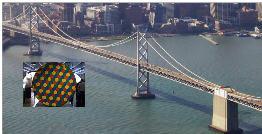
Figura 27- San Francisco – Oakland Bay Bridge: representação da secção transversal dos cabos de suspensão utilizados, constituídos por múltiplos cordões;
