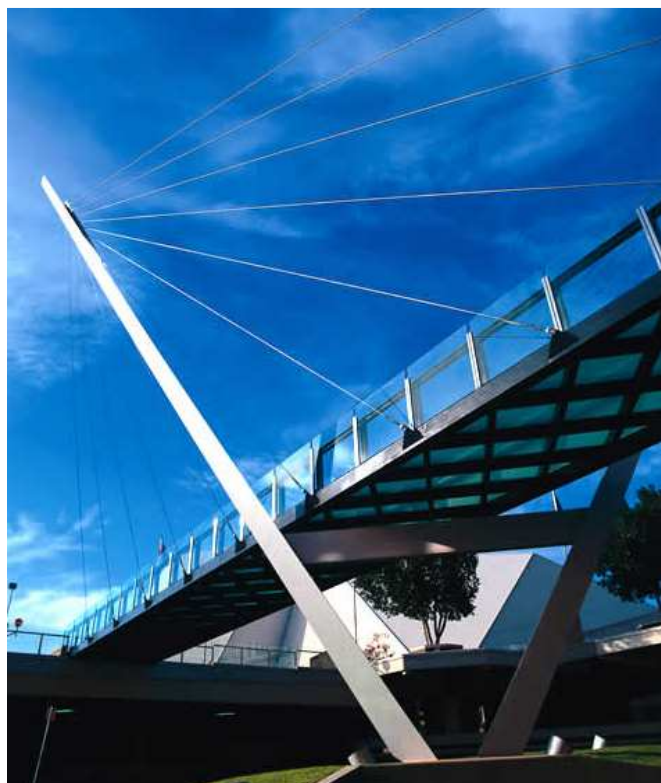
Figura 2.30- Festival Center Footbridge, Adelaide, Austrália: exemplo de uma ponte atirantada moderna;
