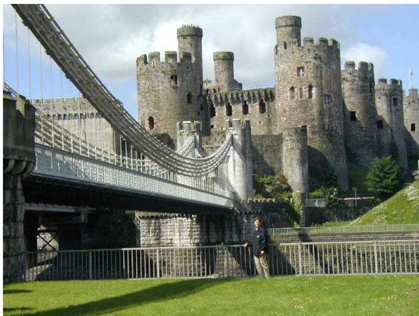
Figura 2.28- Ponte Cowny, Londres;
