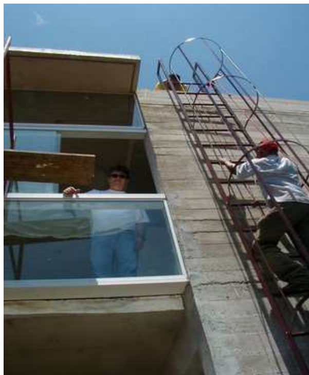
Fig.28 – Montagem da caixilharia
