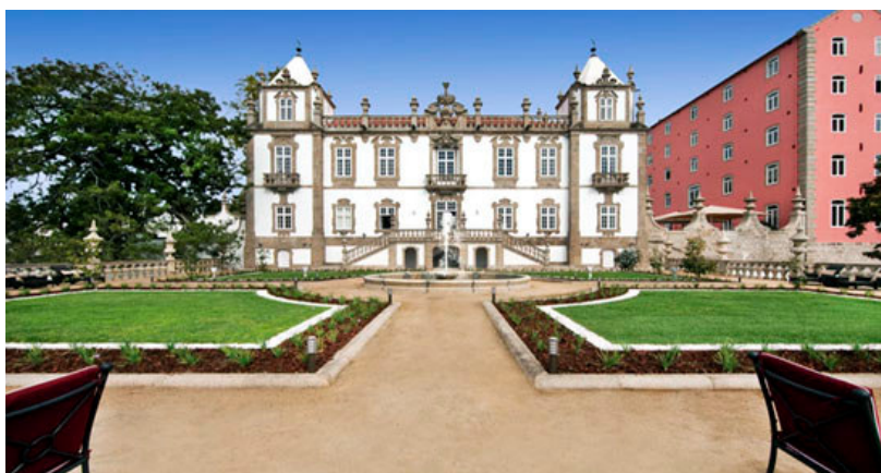
Fig.19 – Foto das fachadas dos dois edifícios da Pousada do Porto [51]
