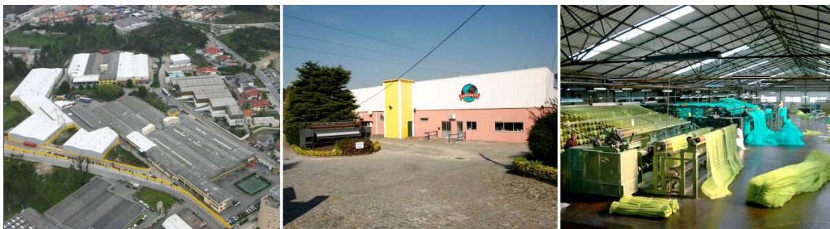
Figura 5 – Parque industrial, exterior e interior de um dos pavilhões da empresa
