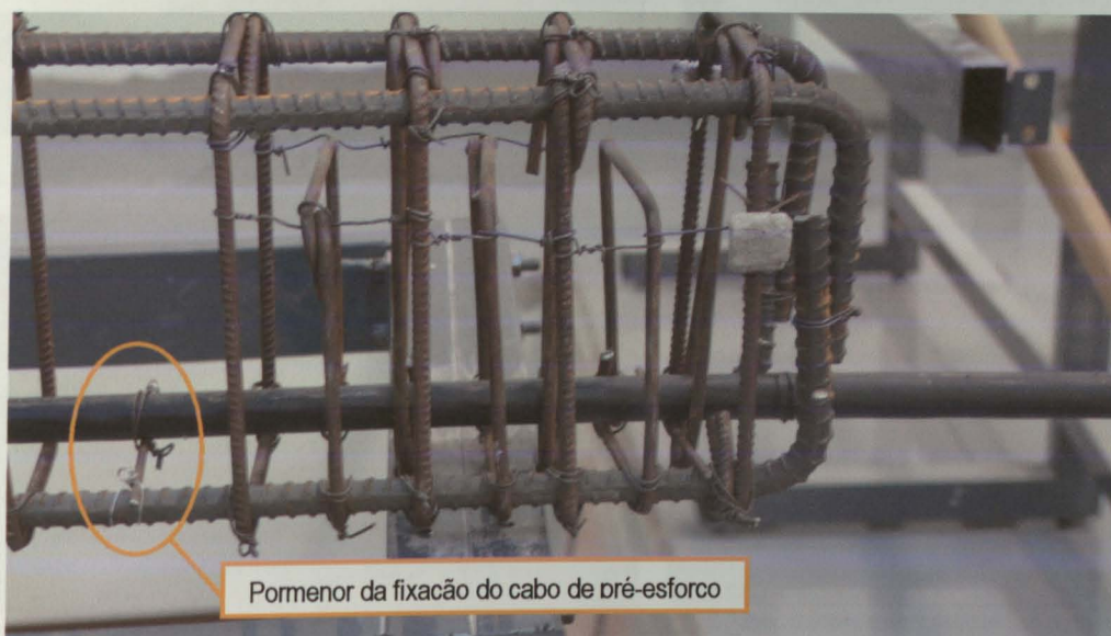
Figura 2 – Pormenor das armaduras na zona de ancoragem
