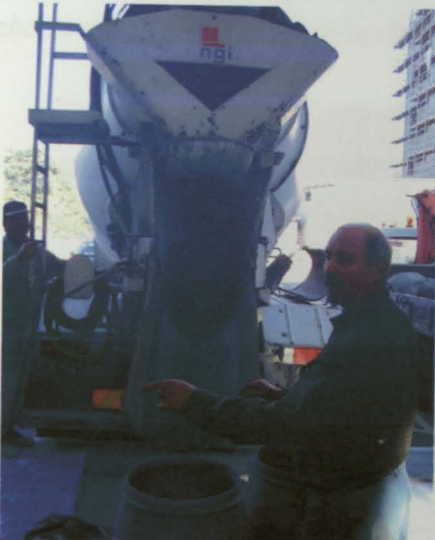
a) Camião que transportou o betão a aplicar na viga
