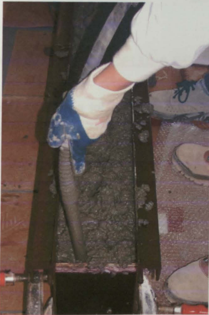
c) Vibração do betão (de forma mais cuidada na zona das ancoragens)
