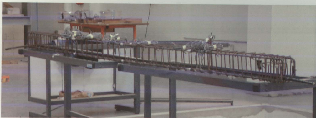
Figura 1 – Aspecto geral das armaduras
