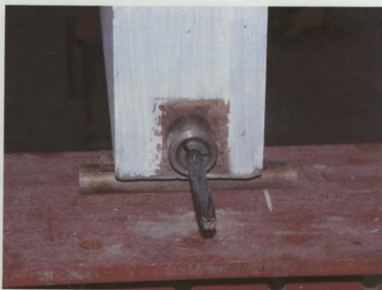
b) Após colocação e ajuste para a aplicação do pré-esforço
