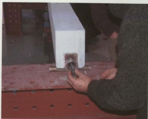
a) Colocação das cunhas
