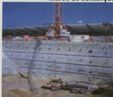
Torre das Antas (Porto - Portugal)
