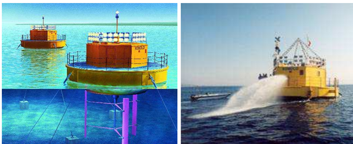
Fig.3.24 – À esquerda: Representação do sistema Kobold , [71]; À direita: Fotografia do sistema em funcionamento, Itália.
