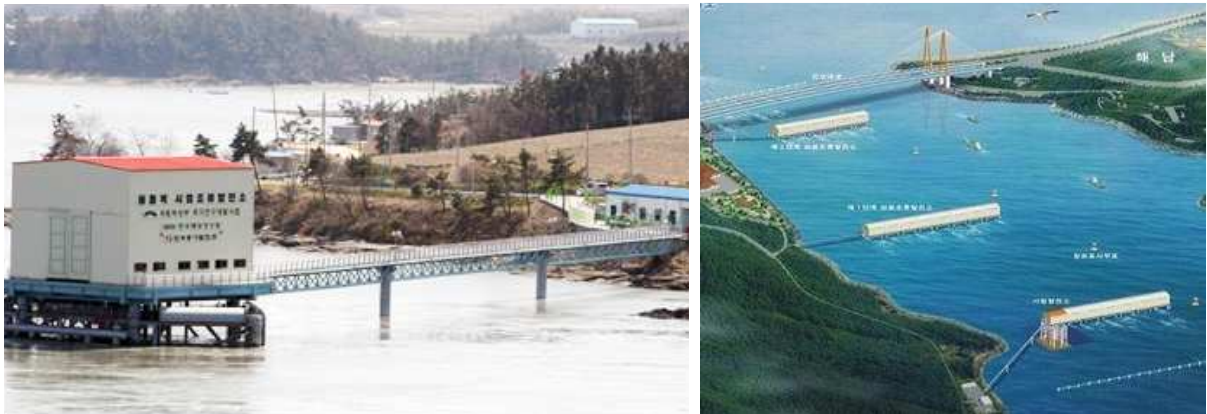
Fig.3.21 – À esquerda, estação de produção de energia através das correntes de maré, à direita representação geral do projecto, Uldomok, Coreia do Sul, [67].
