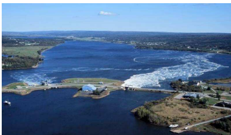
Fig.2.8 – Aproveitamento da Energia das Marés em Annapolis Royal. [25].
