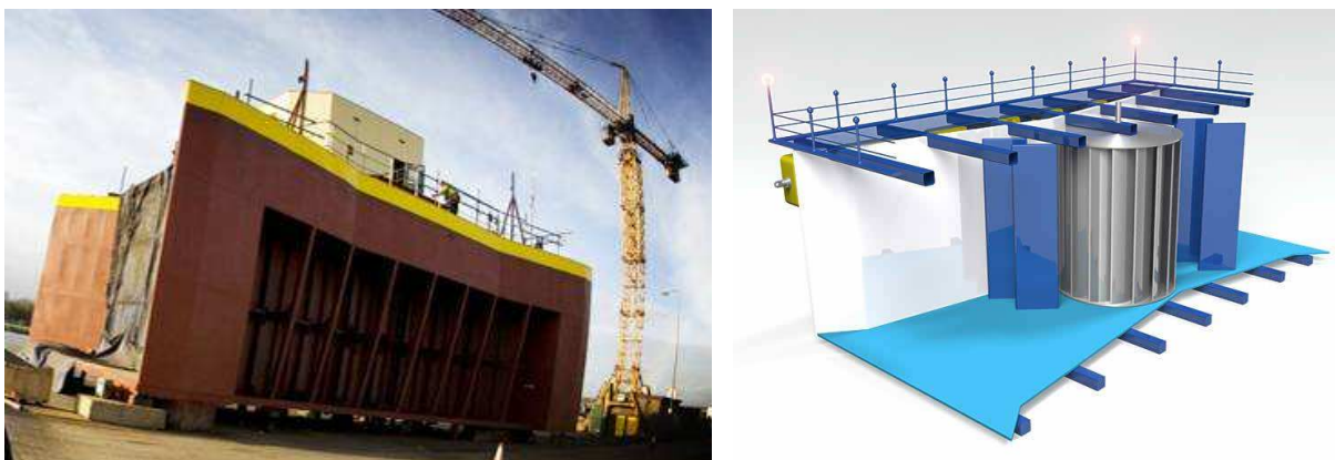
Fig.3.19 – À esquerda: Construção da Estrutura flutuadora, [62]; À direita: Representação de um corte da estrutura onde se pode observar a turbina de eixo vertical no seu interior.
