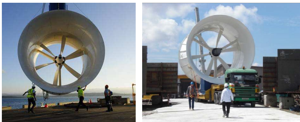
Fig.3.13 – Instalação do sistema AS-400, Singapura, [53].
