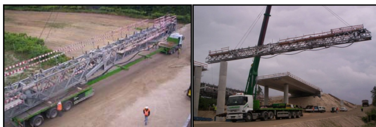
Fig.24 – Colocação da estrutura principal de um cimbra em obra ao qual são posteriormente conectados os “narizes” [20].
