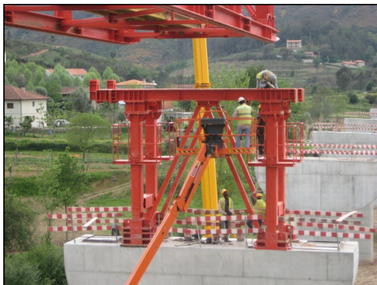
Fig.19 – Montagem do apoio dianteiro de um CA superior.
