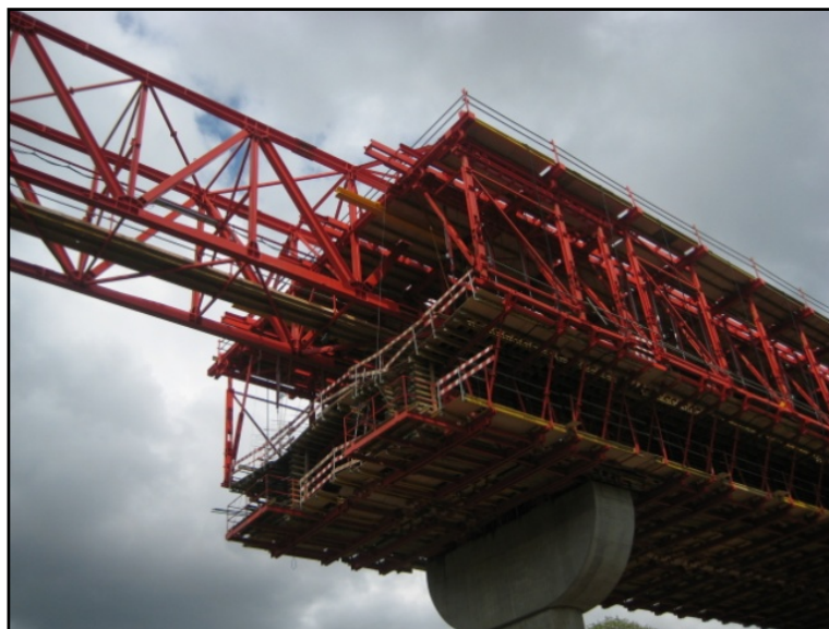
Fig.15 – Cimbra autolanzável na execução de um viaduto em Arco de Baulhe (Mota-Engil, 2008).
