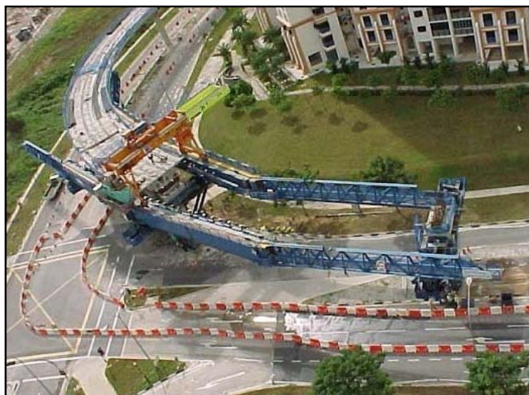
Fig.22 – Viga de lançamento com sistema de articulações permitindo curvaturas com raio mínimo de 75m [17].
