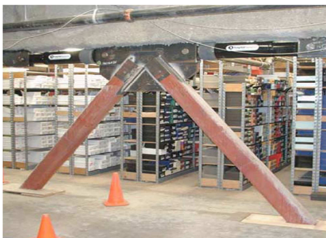
Fig. 12 – Amortecedor viscoso em "K"
