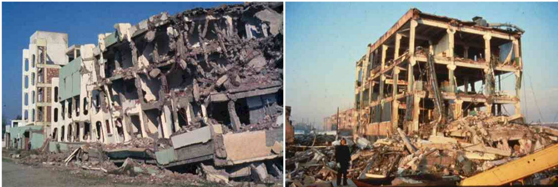
Fig. 18 – Pórticos em betão armado afectados após sismos [11] a) El Asnam, 1980; b) Arménia, 1988
