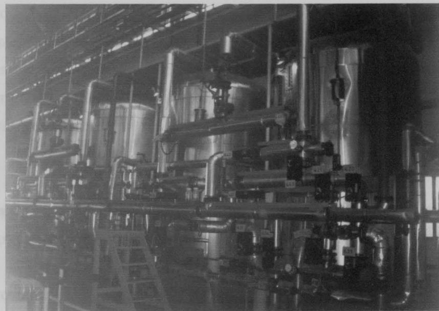
**Figura 7:** Sistema III e IV de Resinas de Permuta Iônica.
