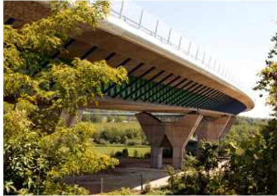
Figure 5: Viaduc de Meaux ;
