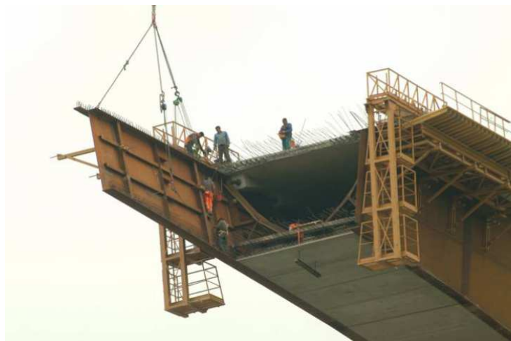
Figure 7: Construction par encorbellement du viaduc Roccaprebalza ; Source : Présentation du Prof. G. Mancini à Naples en décembre 2009
