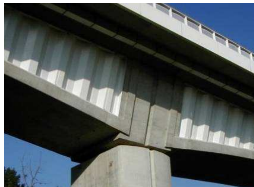
Figure 2: Pont de la Corniche ; source : Jacques Mossot - Structurae
