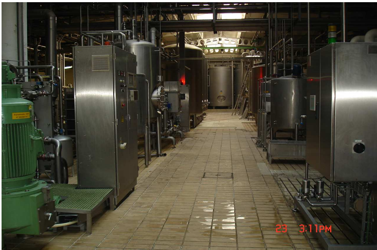
Figura 12 - Instalação da etapa de filtração na fábrica.
