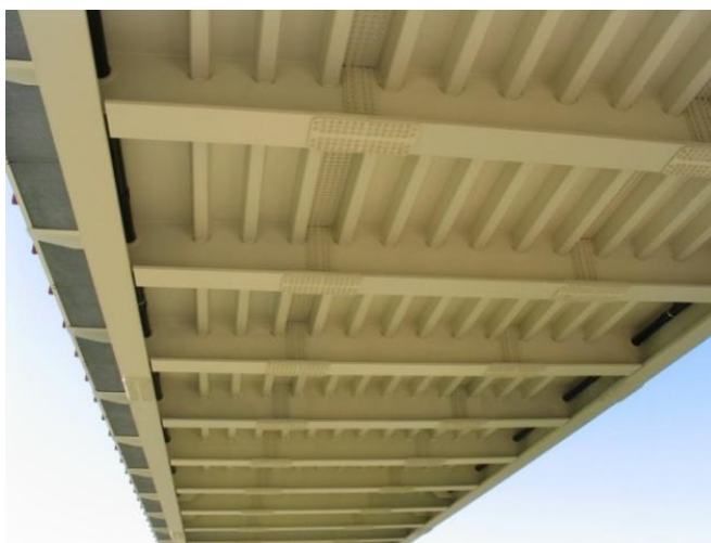
Figura 3. 3: Vista inferior do tabuleiro da Ponte de Prester
