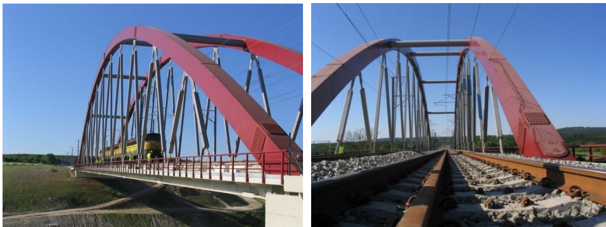
Figura 3. 2: Vista lateral e superior do tabuleiro da Ponte de Prester
