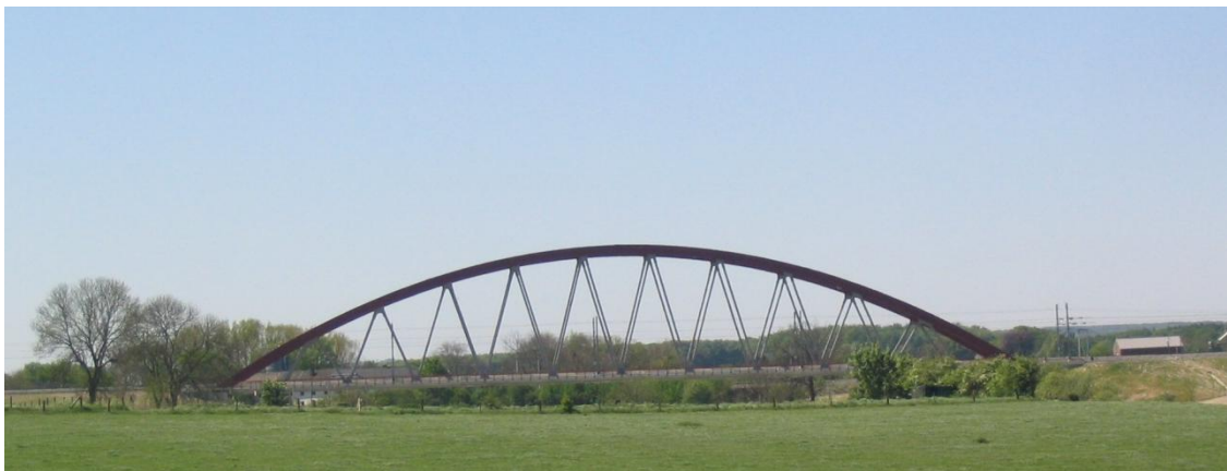
Figura 3. 1: Vista lateral da Ponte de Prester
