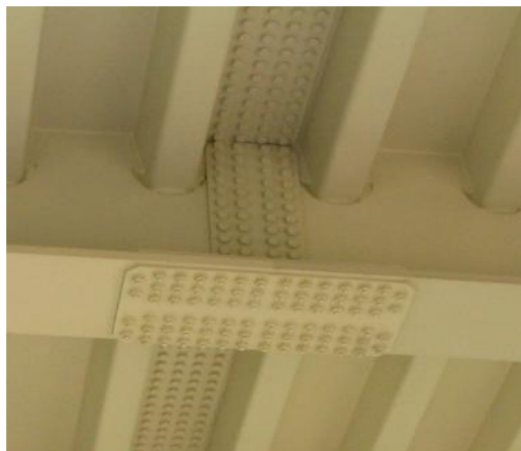
Figura 4.2: Detalhe construtivo da ligação das carlingas
