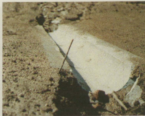
↑ Descida de água num talude de aterro
