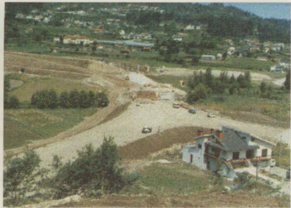
↑ Final ao Km 6 + 314,060; nó tipo trompette entre as E.E.N.N. 207/106
