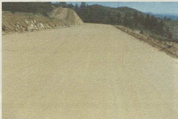
↳ Camada de coroamento em aterro
