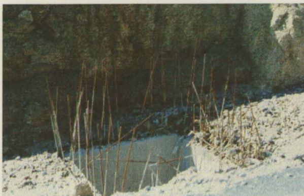
↑ Colector de águas, em fase de execução
