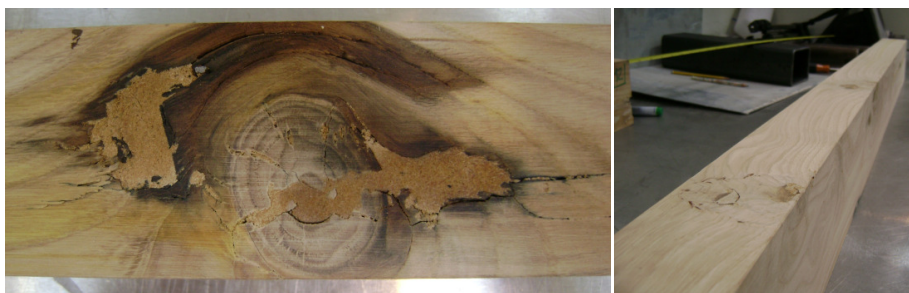
Fig.4.8 – Tipo de registo fotográfico realizado. Esquerda: pormenor de um defeito; Direita: vista geral de uma viga
