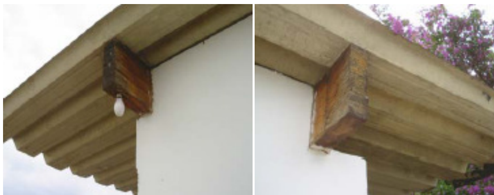
Fig.2.18 – Degradação provocada por agentes abióticos: à esquerda acção da chuva; à direita acção da radiação solar
