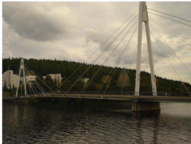
Fig. 2.18 - Ponte pedonal atirantada na Finlândia
