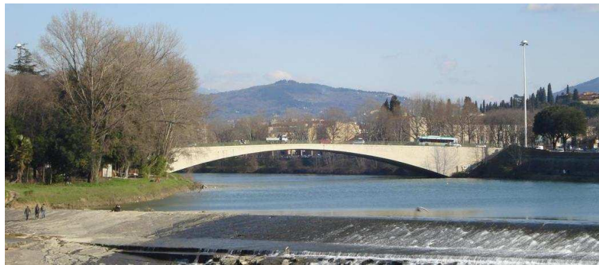
Fig. 2.12– Ponte em arco sobre o Rio Arno, Florença
