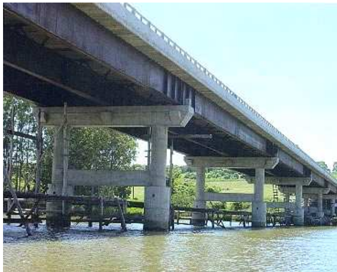
Fig. 2.3 – Ponte sobre Barragem Maia Filho, Rio Grande do Sul, Brasil
