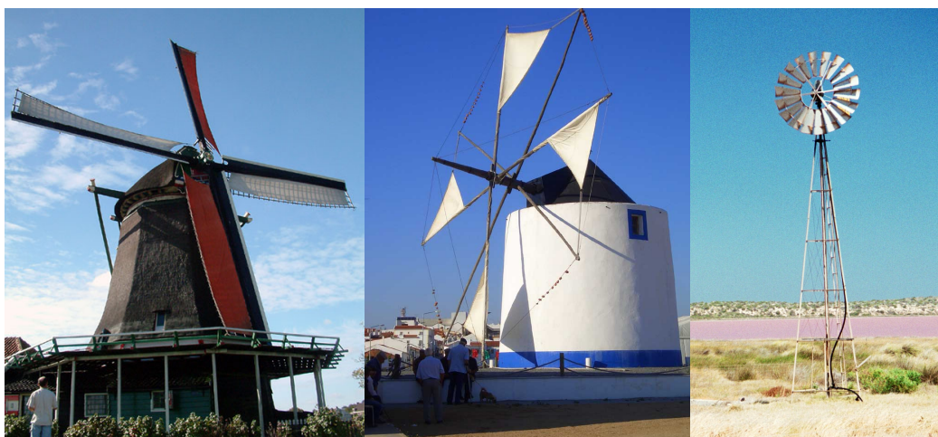
Figura 1 – Exemplos de usos tradicionais da energia eólica: moinho holandês para drenagem, moinho português de moagem, moinho agrícola de bombagem (usualmente designado de estilo americano).
