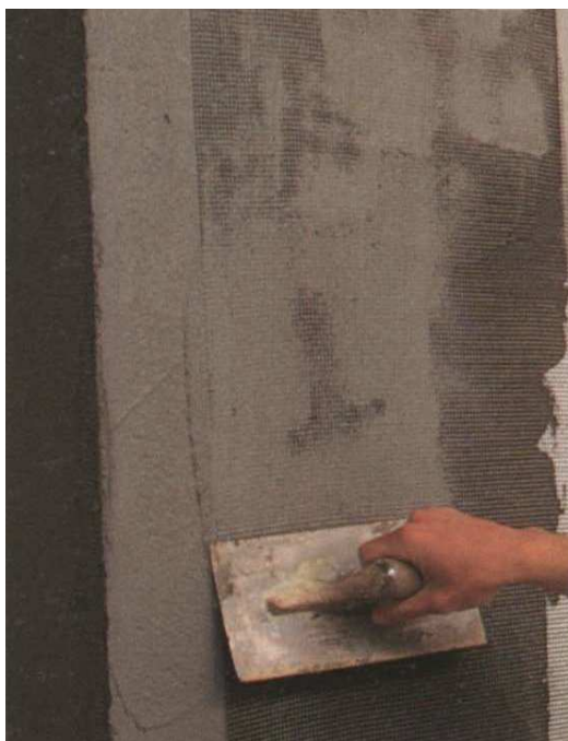
Fig. 3.16 – Aplicação da segunda demão da camada de base
