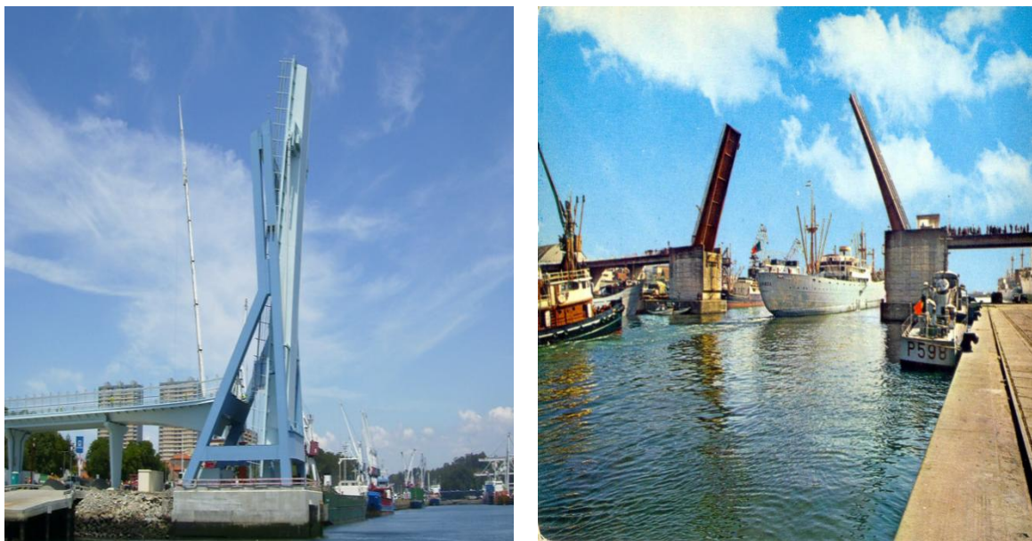
Figura 2.6 – Aspectos da antiga (esquerda) e nova (direita) pontes móveis sobre o porto de Leixões –[23]
