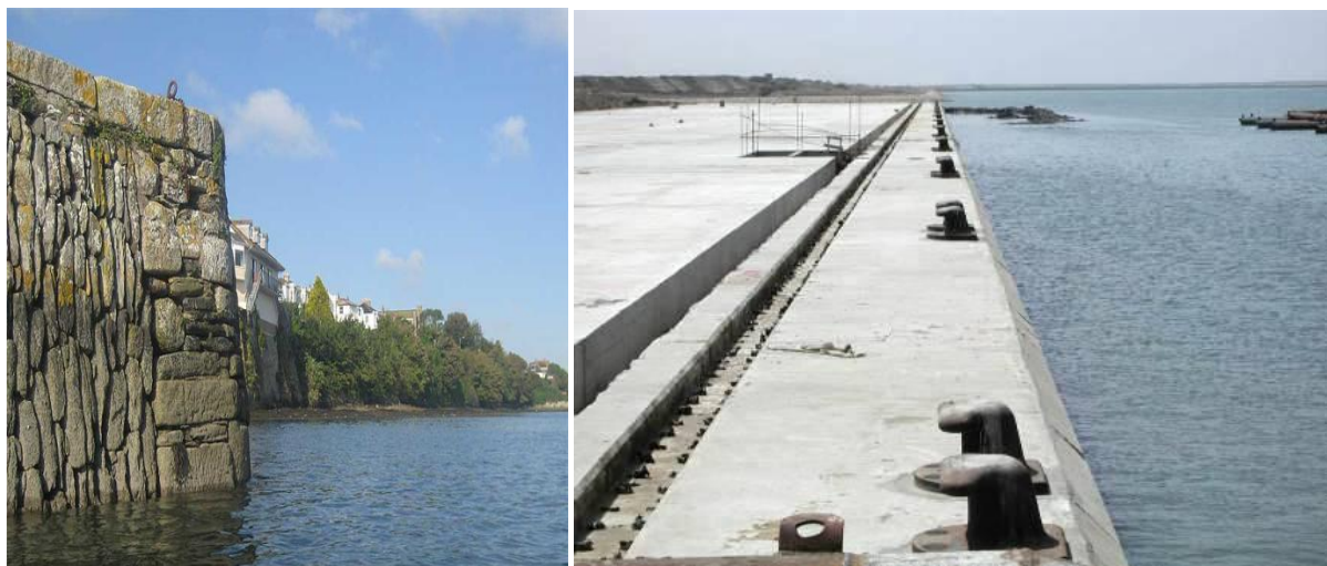
Fig. 3.1 – Estruturas de acostagem em blocos: naturais (esquerda) e artificiais (direita) – [13].
