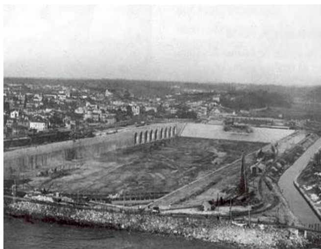
Figura 2.7 – Aspecto da doca nº 1 no período de construção- [23].
