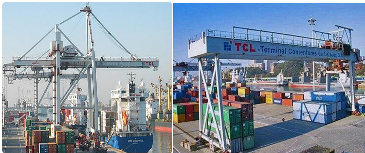
Figura 2.15 – Apoio mecânico presente no terminal de contentores Sul – [23].
