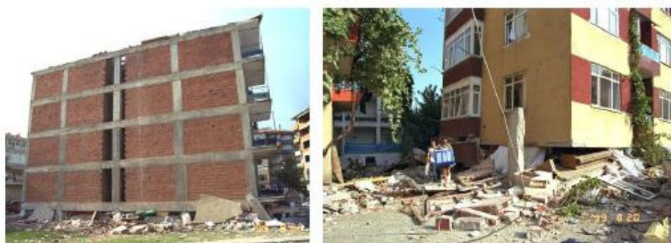
Figura 2.4 – Mecanismos de “soft-storey” (Rodrigues, 2005).
