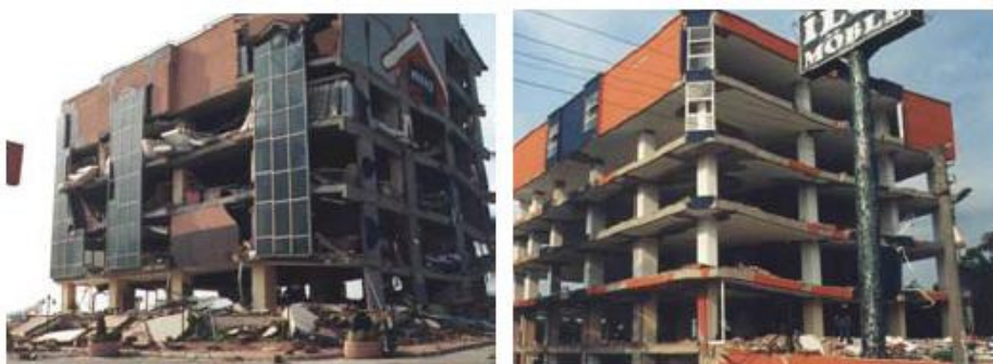
Figura 2.1 – Colapsos de paredes de alvenaria para fora do plano após a rotura devido à acção sísmica (Varum, 2003).
