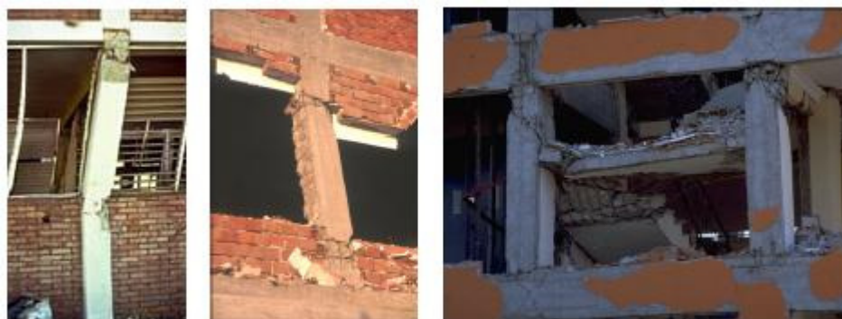
Figura 2.3 – Mecanismos de pilar curto devido a aberturas nos painéis de alvenaria (Varum, 2003).
