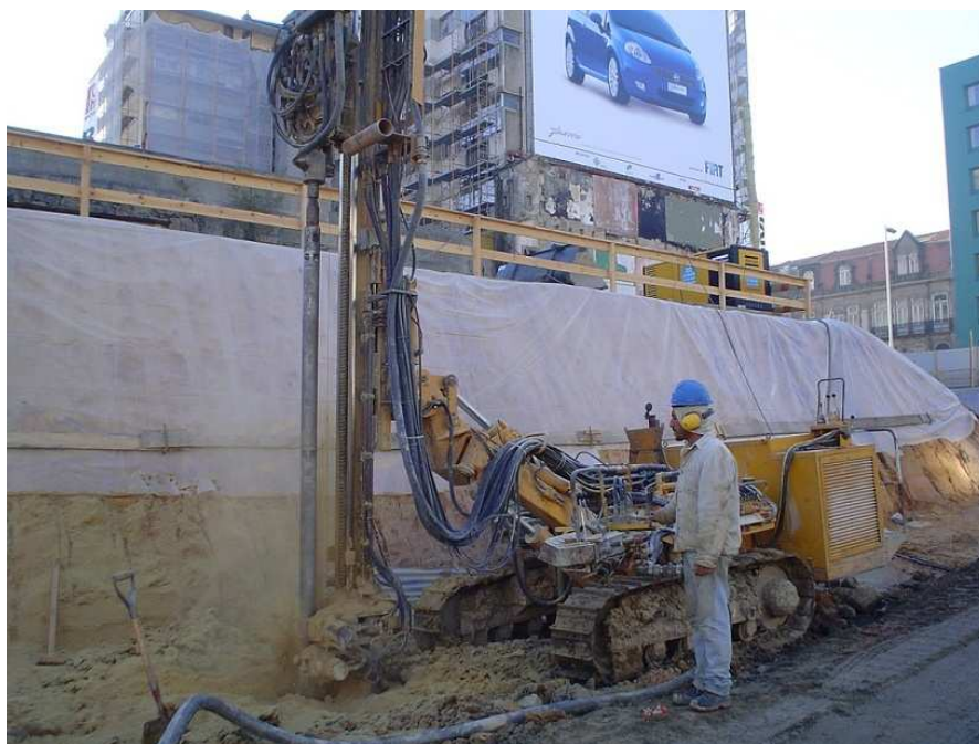
Fig.3.17 – Foto da furação para a execução dos perfis metálicos verticais na obra em análise.
