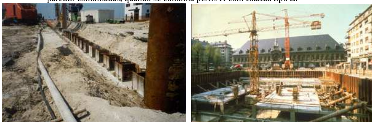
Fig.3.7 – Exemplo de obras com estacas-pranchas
