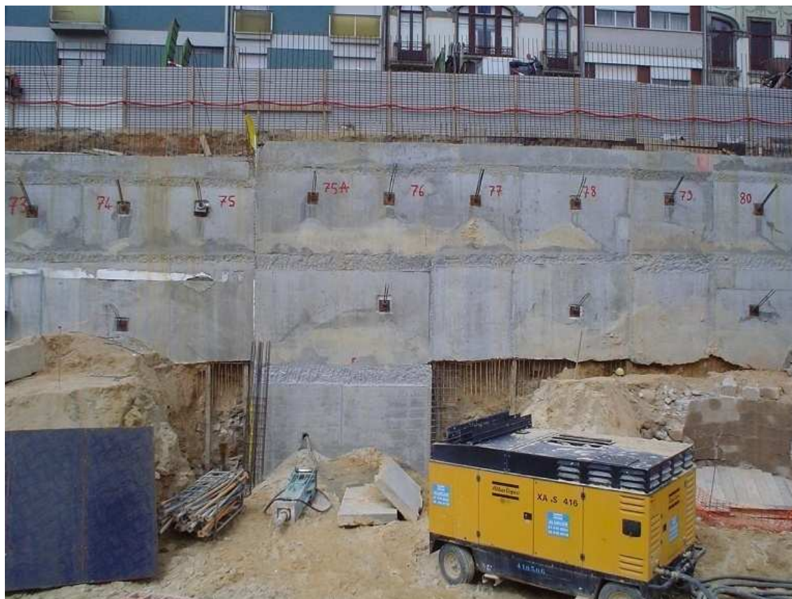
Fig.3.21 – Foto da construção do terceiro nível de painéis
