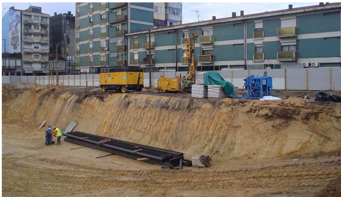
Fig.3.16 – Foto da obra em análise no início do processo de escavação
