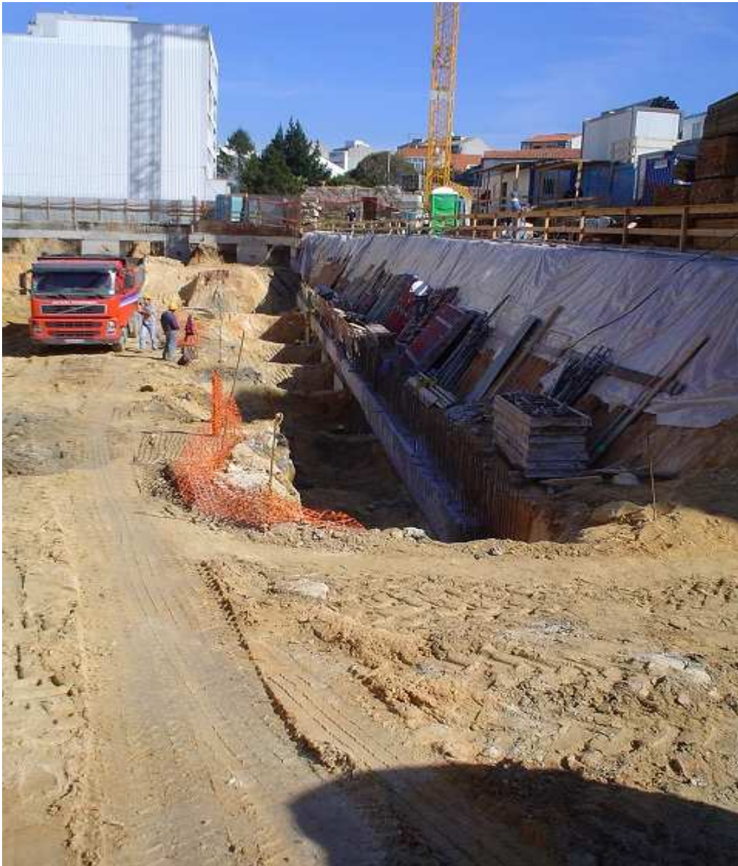
Fig.3.18 – Foto da fase inicial da obra com execução da viga de coroamento
