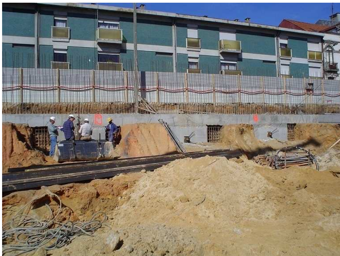
Fig.3.19 – Foto do aspecto geral da obra, observando-se o faseamento de painéis primários e secundários
