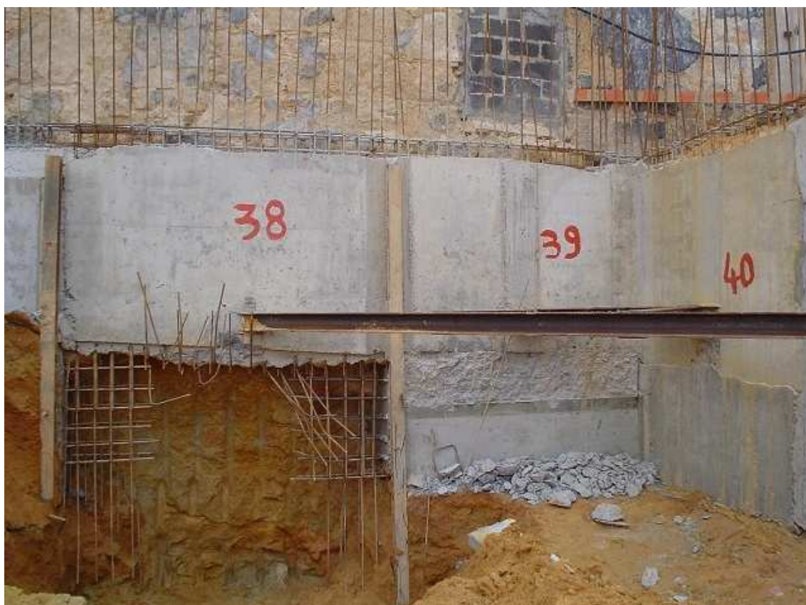
Fig.3.20 – Foto das armaduras de recepção de ligação aos painéis subsequentes
