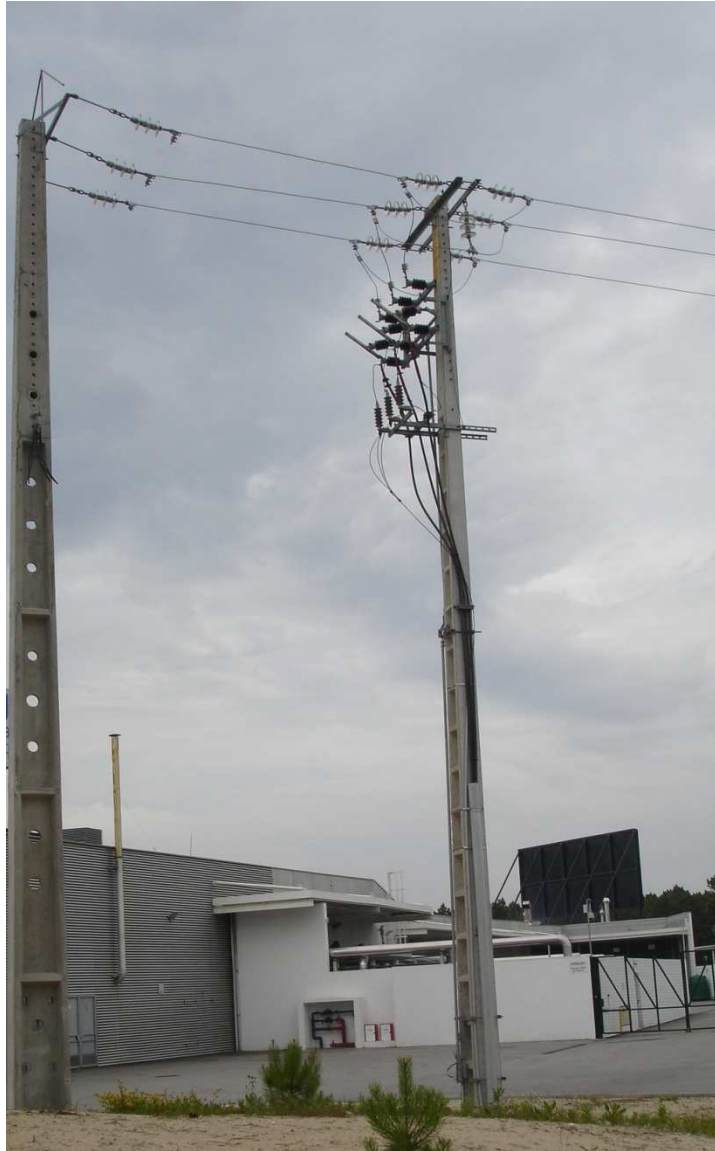
Figura 3.3 – Transição aéreo – subterrâneo com seccionador e DST.
