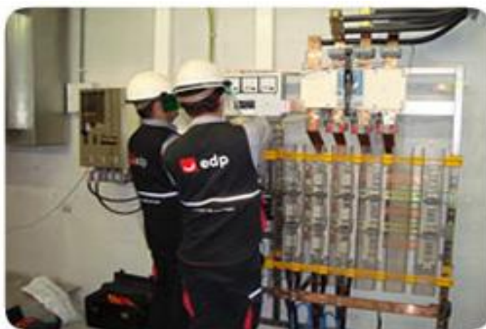
Figura 9.1.1.1.3 - Equipa montando no QGBT o DTC
