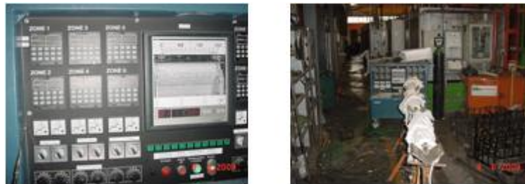
Figura 20. Unidade de tratamento térmico utilizada e montagem do PWHT.
