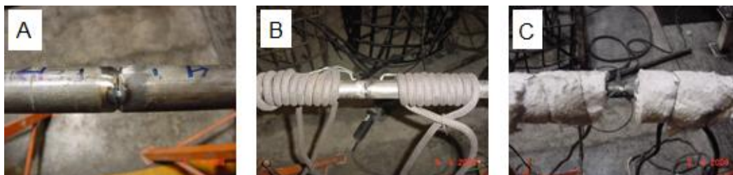
Figura 18. Preparação e montagem do pré-aquecimento com resistências eléctricas “one-line”.
