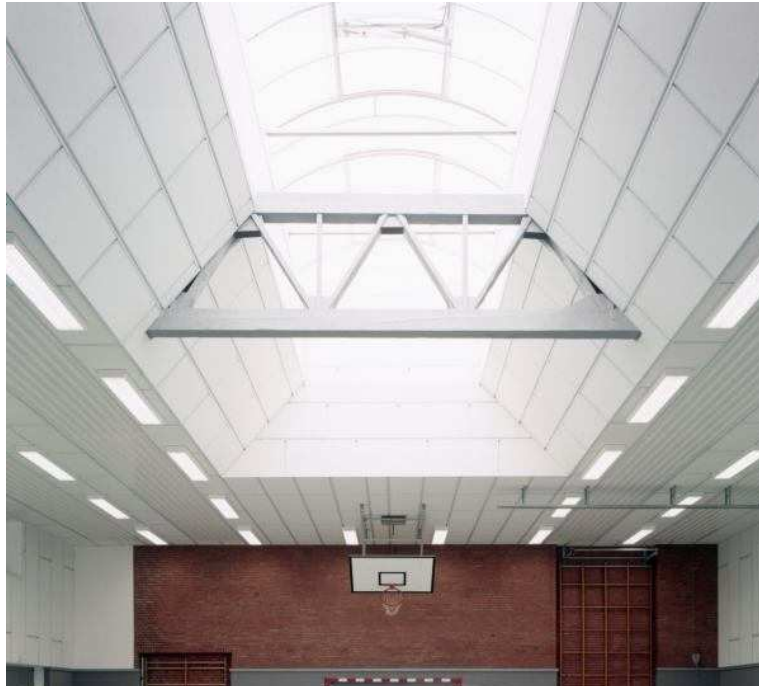
Fig. 5.5 – Ginásio com placas de 2 e 4 cm com alta densidade de lã de vidro e um NRC de 0,85 [64]
