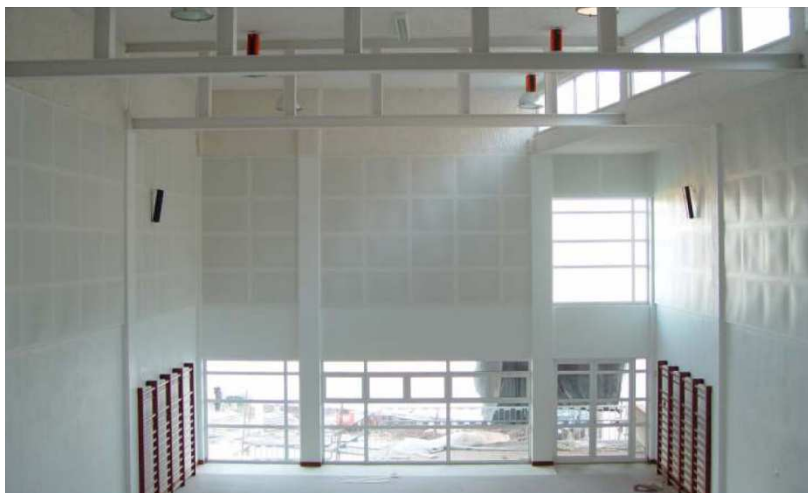
Fig. 5.7 - Aplicação de K13 na Escola EB1 de Loures [71]
