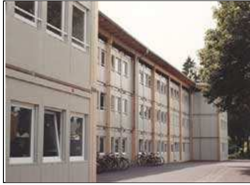
Fig.7.4 - Escola edificada a partir de diversos contentores [66]
