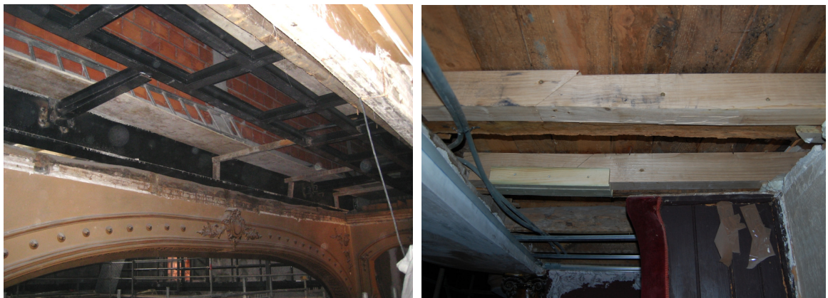
Fig. 6.14 – Estrutura que serve de passagem para circulação na zona de cobertura (à esquerda), à direita reforço dos apoios das vigas dos pavimentos com elementos metálicos
