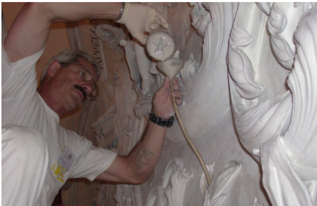
Fig. 5.5 – Injecção de argamassas a base de cal. Cine-Teatro do Fafe.
