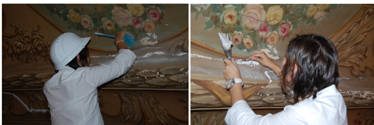
Fig. 6.26 – Limpeza (à esquerda), à direita preenchimento das fendas e fissuras
