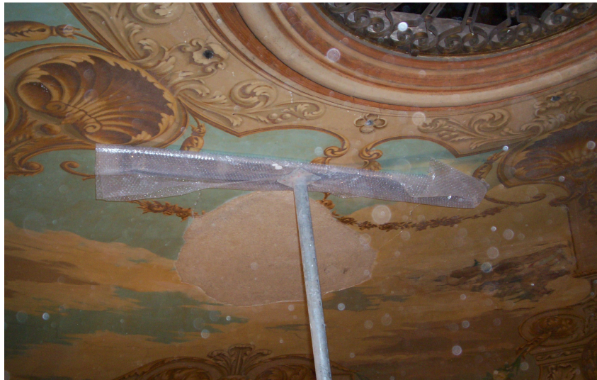
Fig. 6.27 – Escoras de suporte do tecto durante os trabalhos de reabilitação
