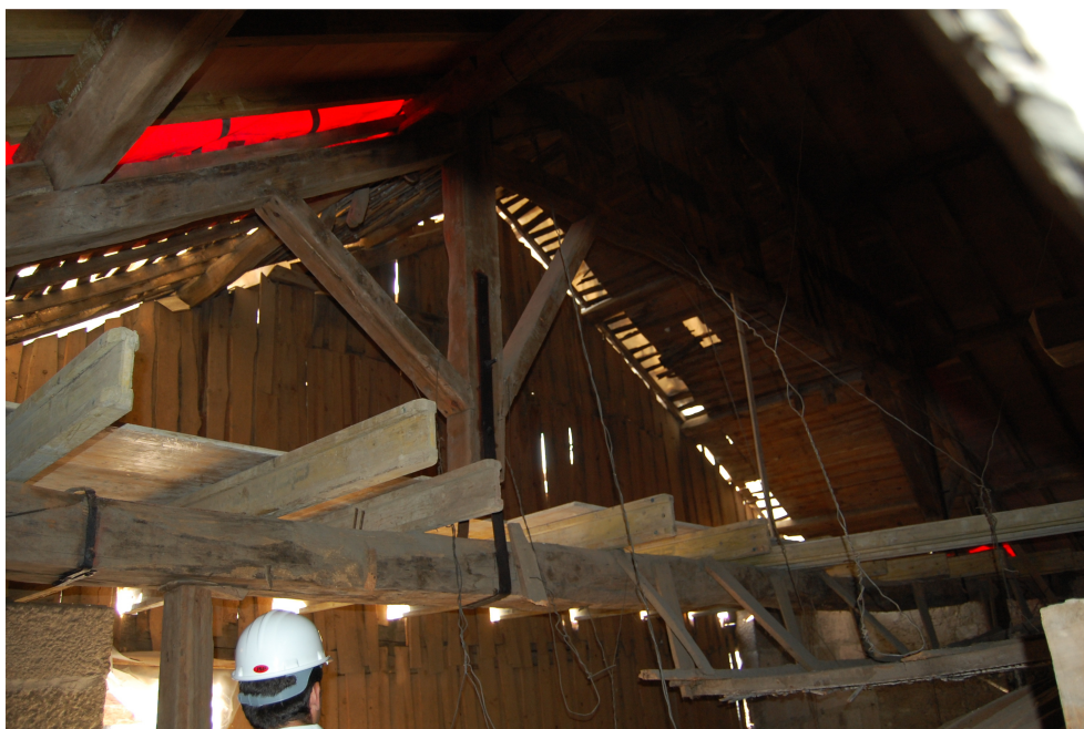
Fig. 6.21 – Beneficiação da cobertura
