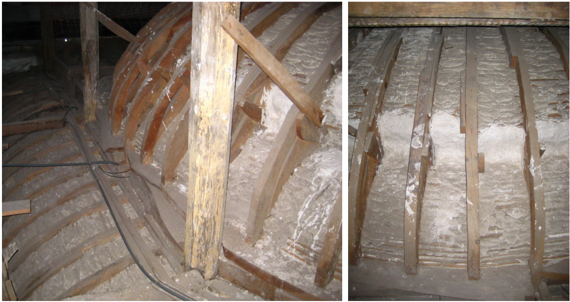
Fig. 6.13 – Reverso da abóbada e seu escoramento aos pilares.
