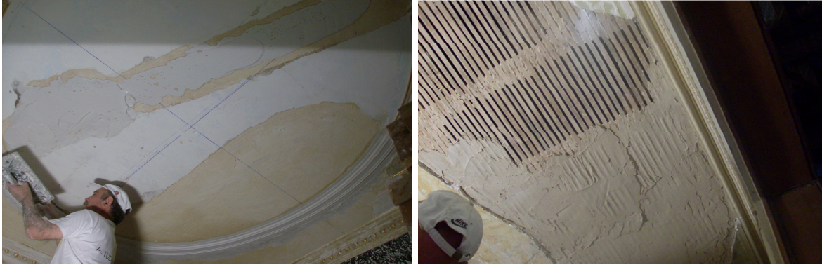
Fig. 5.11 – Preenchimento de lacunas com argamassas. Cine-Teatro de Fafe.
