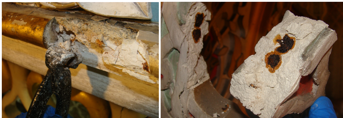
Fig. 5.3 – Remoção dos elementos oxidadas. Palácio da Bolsa do Porto.
