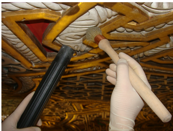
Fig. 5.1 – Limpeza manual e mecânica. Palácio da Bolsa do Porto.
