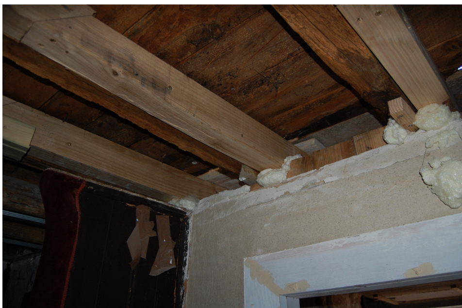
Fig. 6.23 – Consolidação das vigas de madeira
