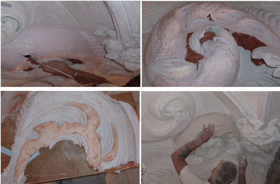
Fig. 5.16 – Execução de moldes para reprodução de elementos em falta, execução de elementos em falta em tudo idênticos aos originais e posterior colocação.
