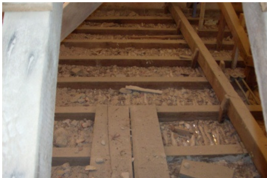
Fig. 5.8 – Limpeza e desinfestação do tardo. Cine-Teatro de Fafe.
