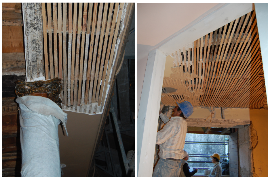
Fig. 6.25 – Reposição de suportes fasquiados (à esquerda), à direita barramento com massas bastardas
