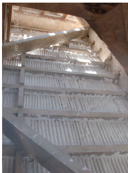
Fig. 5.6 – Consolidação das madeiras e argamassas. Cine-Teatro de Fafe.
