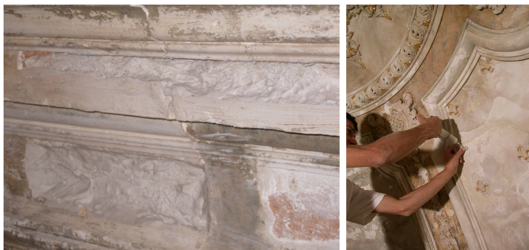
Fig. 5.10 – Tratamento de fendas e fissuras. Cine-Teatro de Fafe.
