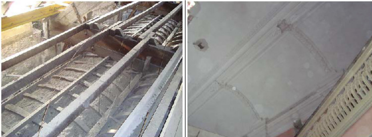
Fig. 3.13 – Tecto Sanqueado. Vista de cima, vista de baixo
