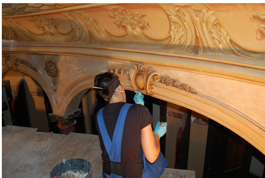
Fig. 6.29 – Limpeza das superfícies
