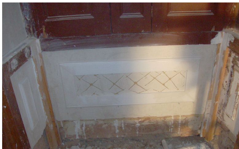
Fig. 5.12. – Preenchimento de lacunas com argamassa. Cine-Teatro de Fafe.
