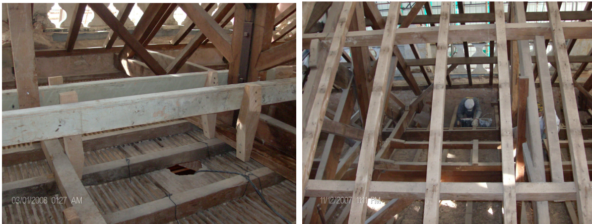
Fig. 5.9 – Elementos estruturais de madeira de suporte a tecto estucado - exemplos
