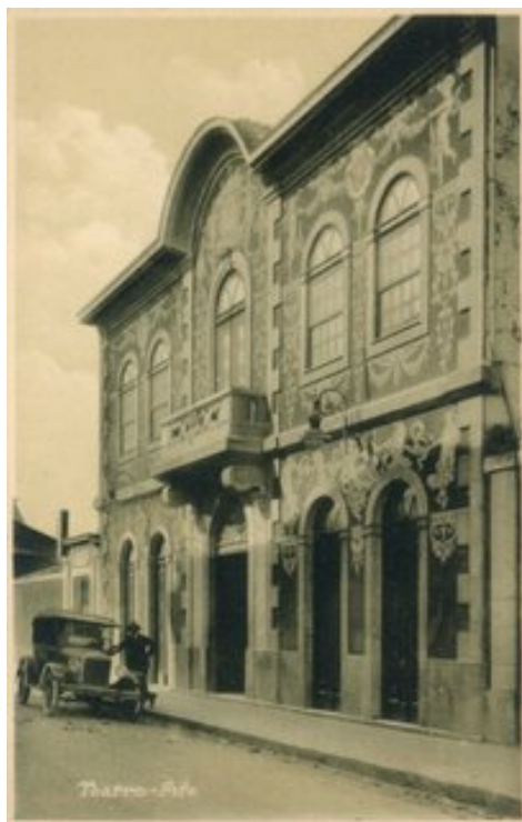
Fig. 6.1 – Fotografia de época da fachada
