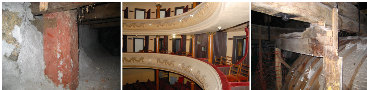
Fig. 6.16 – Base do pilar (à esquerda). Ao centro encontra-se pormenor de ornamentação do pilar e à direita Topo dos pilares e sistema de travamento.
