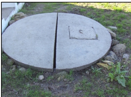
Figura 5.9 – Poço Sumidouro (fonte: AdML)
