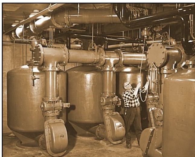
Figura 2.5 – Ejector Pneumático de Grandes Dimensões (notar o operador) (Yeomans Pump, 2007)
