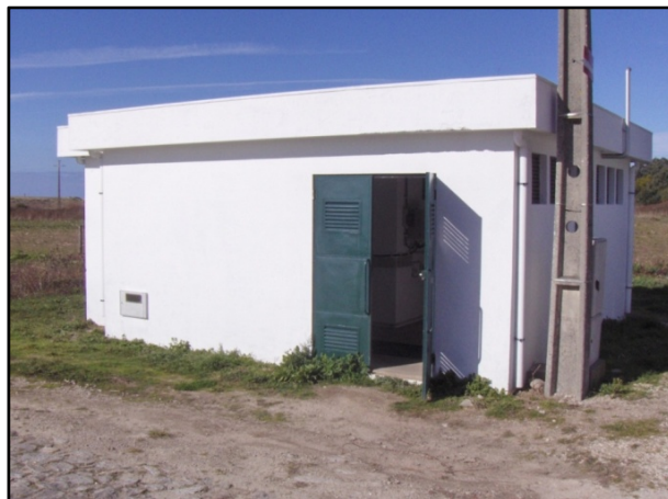
Figura 5.2 – Edifício de Apoio da EE de Afife (fonte: AdML)
